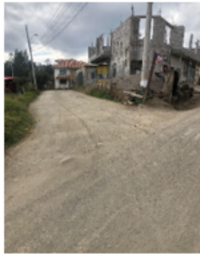
Inspección del lugar del proyecto
