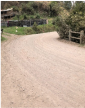
Estado actual de la vía
