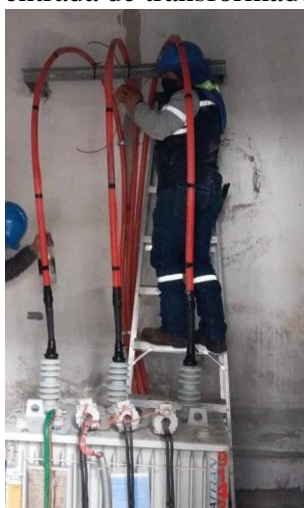
Ilustración 12. Conector tipo interno para conectar al casquillo del transformador (CNEL EP - 2022)
