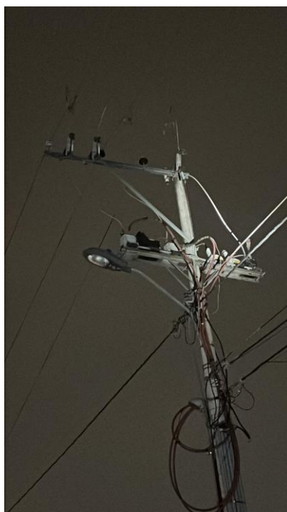
Ilustración 4, Estructura centrada pasante de media tensión
