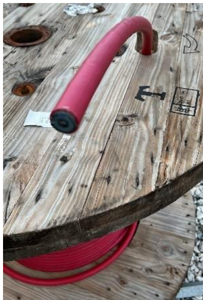
Ilustración 14. Tendido de cable de media tensión (Subestación Villa club). Fuente: Autor
