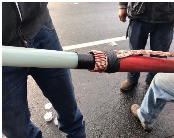
Ilustración 15. Colocación de cable de voltaje medio. (CNEL EP-2020). Fuente Autor
