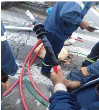
Ilustración 13. Conexión de estilo externo. (EEASA-2020).
