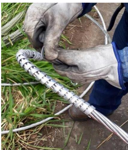
Ilustración 3 Conductor de aluminio destinado a ser utilizado en sistemas de media tensión. (EEASA-2020). [62]
