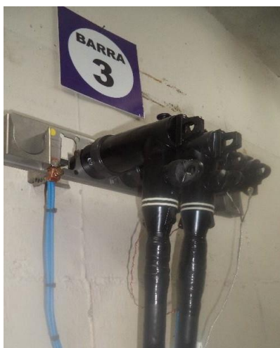
Ilustración 11, Conexión de tipo codo (CNEL EP-2022) Autor: Consorcio DG.
