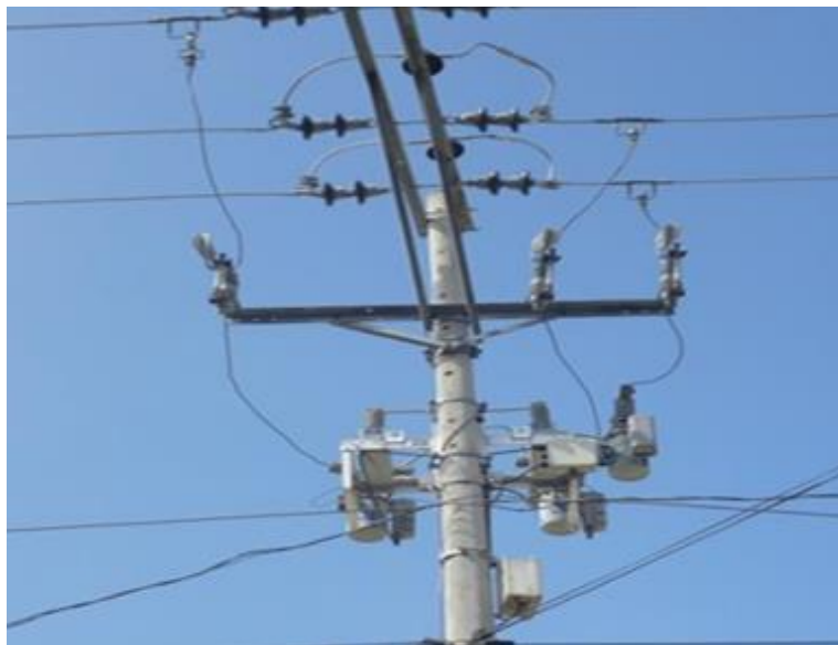
Figura 6. Cruceta centrada. Cruceta centrada. [9]
