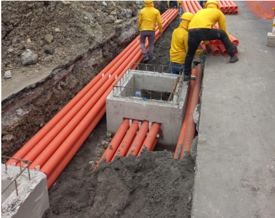
Figura 10. Canalización de redes. [14].
