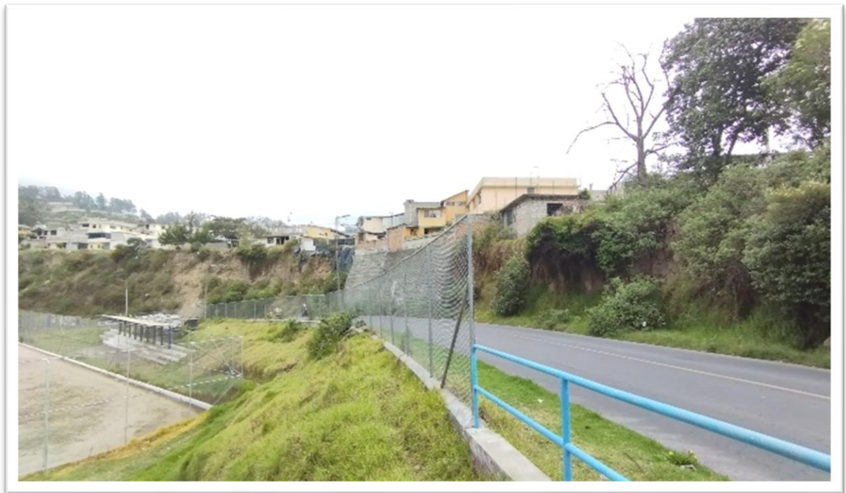
Nota: Vista general desde la base de los taludes de la calle Julio Ramos
