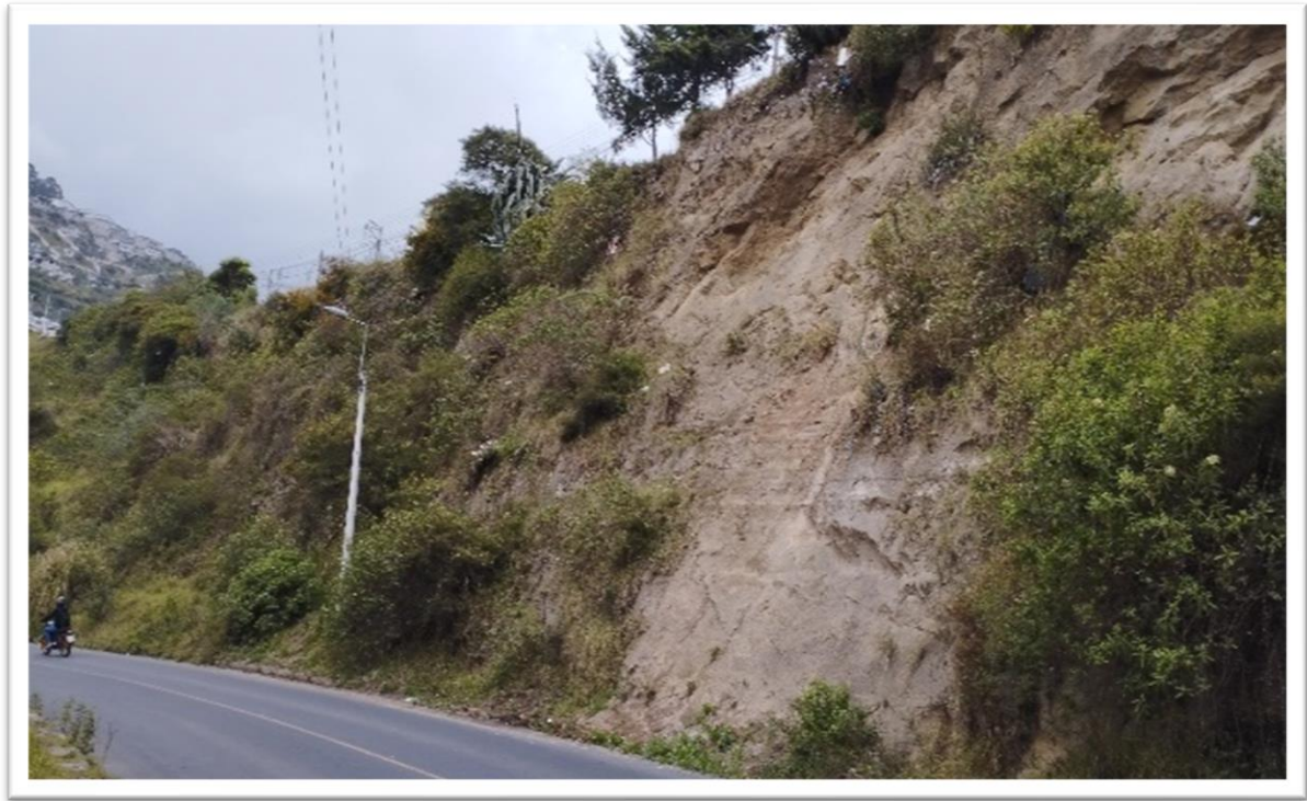
Nota: Vista frontal de la zona más crítica de los taludes
