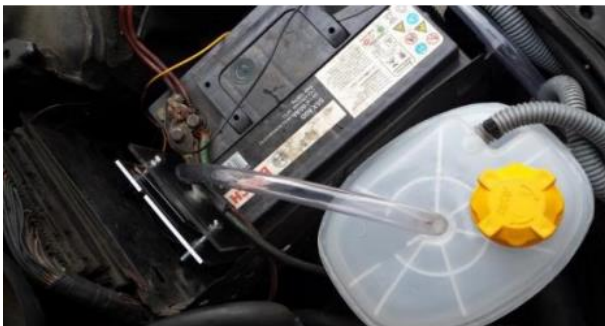
Figura 1. Generador de hidrógeno instalado. [21]
