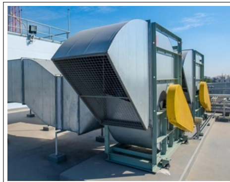
Figura 4. Aberturas de Entrada y Salida [20]
