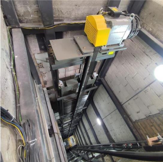
a) Motor montado en la estructura
