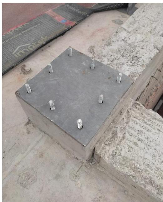
d) Ubicación y nivelado de la placa de anclaje para estructura que será instalada en la terraza. Se usa grout autonivelante para su instalación y asentamiento uniforme
