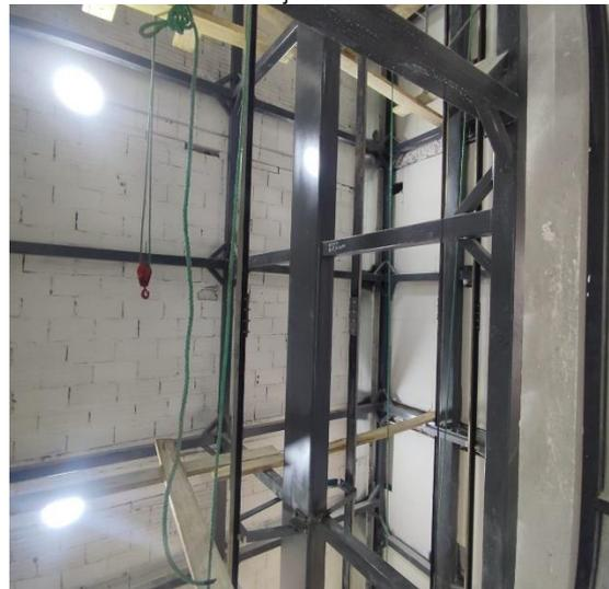
d) Instalación de soportes y guías de cabina en columna central del eje X2.
