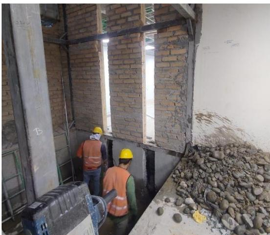
e) Adecuaciones de los muros antiguos para el montaje de las columnas en los ejes X1 y X2. La columna central está posicionada.
