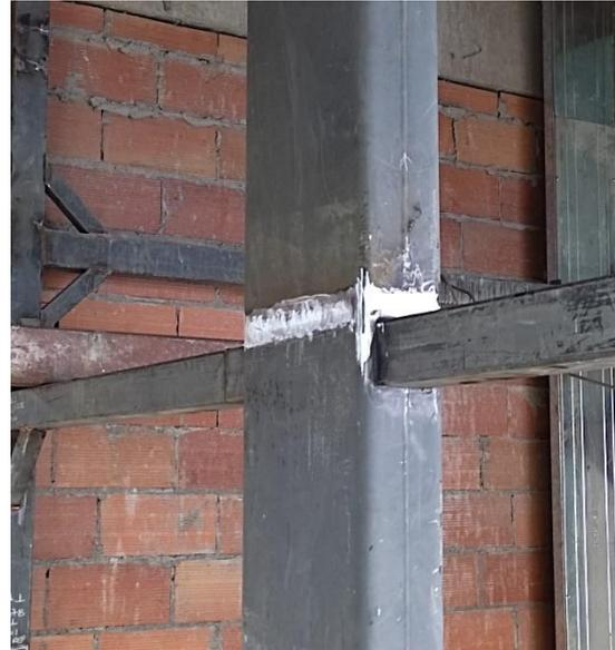
b) Conexión Columna-Columna con el cordón pulido. Las dos viguetas que están conectadas no deben estar cerca a la conexión. Por lo tanto fueron desplazadas
