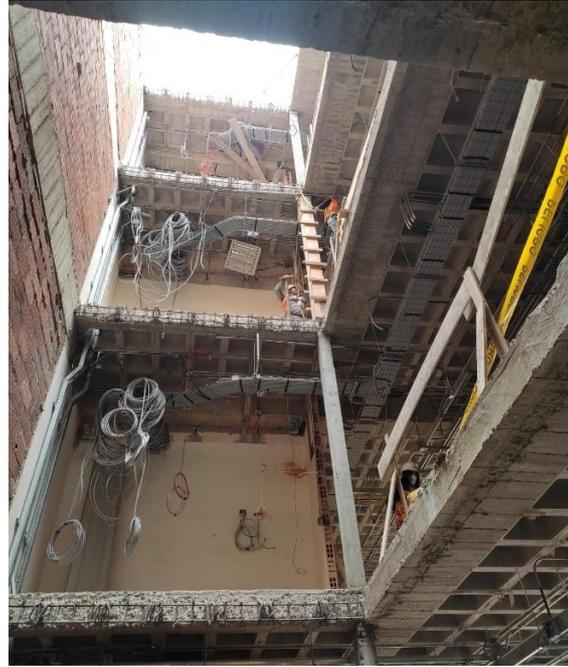
d) Demolición de remates de losas para expandir el ducto del ascensor dúplex.
