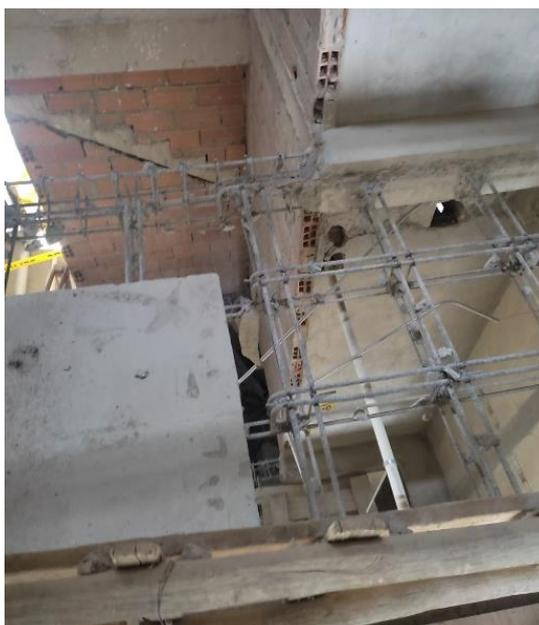
b) Tramos de losas de entrepiso en estado de demolición, el acero de los nervios no se ha cortado hasta soportar la losa con una nueva columna
