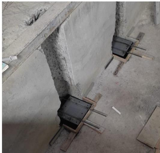
b) Ubicación y nivelado de placas base de columnas HSS200x150x8 en el eje X1.
