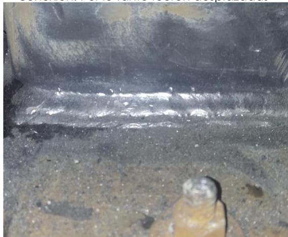
d) Pulido del cordón de conexión Columna-Placa base para conseguir perfil cóncavo
