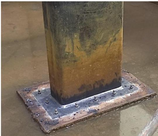
c) Conexión Columna-Placa base
