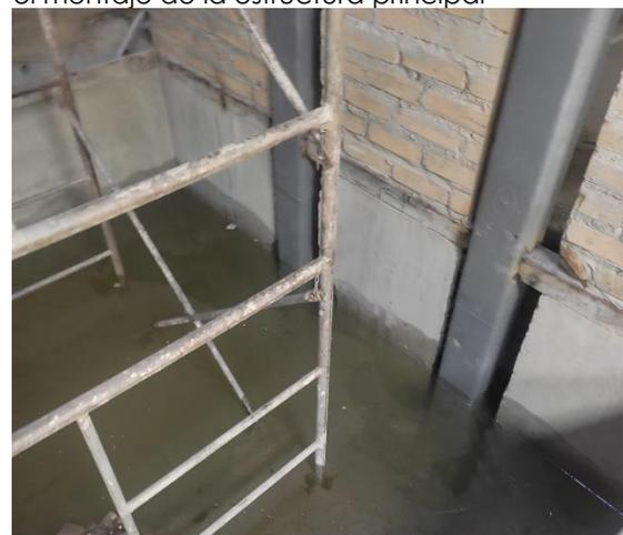
f) Columnas principales en eje X3 posicionada. El nivel freático se hace evidente en el subsuelo.
