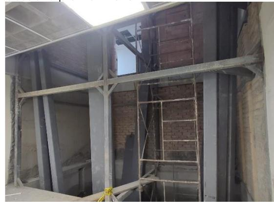
d) Estructura secundaria armada y lista para el montaje de la estructura principal
