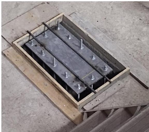
a) Ubicación y nivelado de placa base para columna centra HSS400x150x8 en el subsuelo de la edificación
