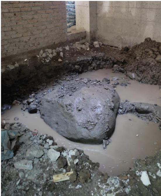
e) Durante la excavación de la cimentación se encontró material pétreo imposible de sacar en un solo pedazo por el espacio limitado al interior de la edificación.
