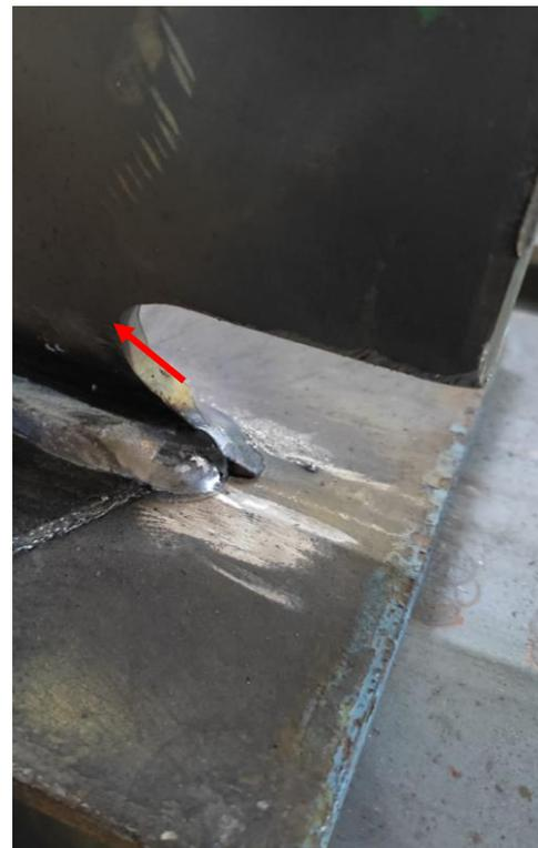
f) Existencia del radio en el extremo de la viga a ser conectada con la columna.
