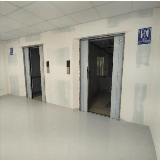
c) Cabinas montadas en los ductos
