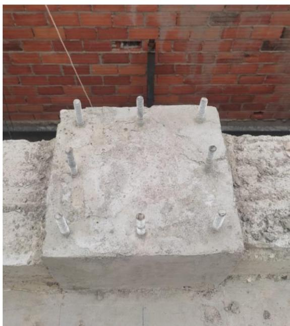
c) Dado en nueva cimentación de estructura de hormigón de la edificación.
