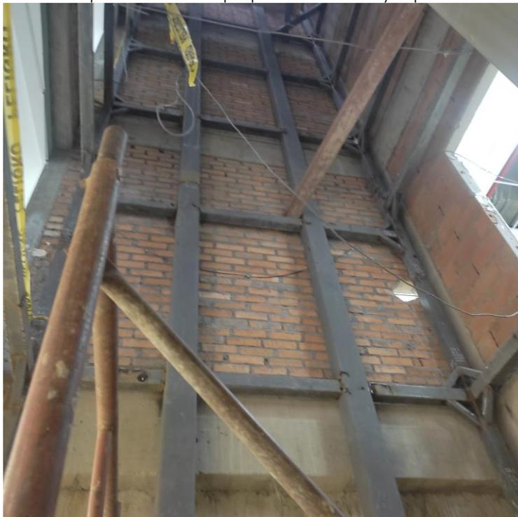
b) Verificación de perpendicularidad de columnas
