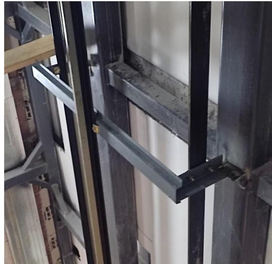
b) Soporte de guía de contrapeso y guías en eje X3.
