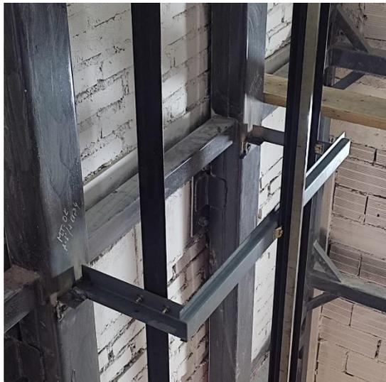
c) Instalación de Soporte y guía de contrapeso y cabina en eje X1
