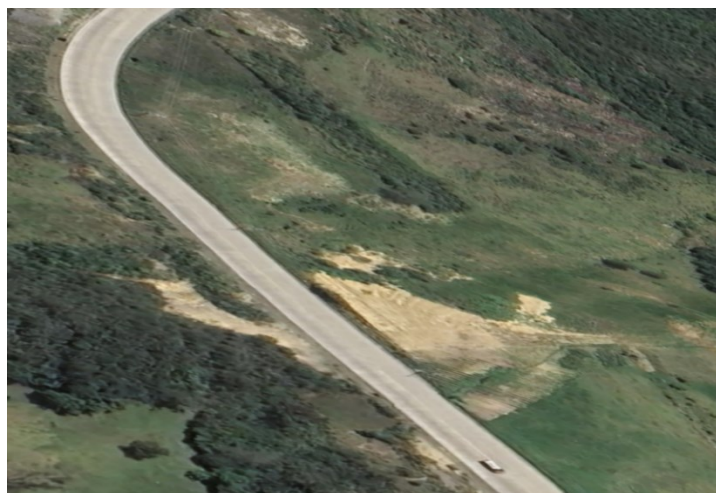
Figura 23 Deslizamiento de flujo rápido en Cumbe.
