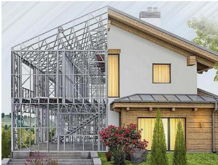
*Nota.* En el lado izquierdo se observa la estructura en Steel Framing. Fuente: Alacero (2007).
