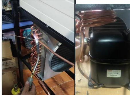
**Figura 41** suelda de tubería de cobre del sistema
