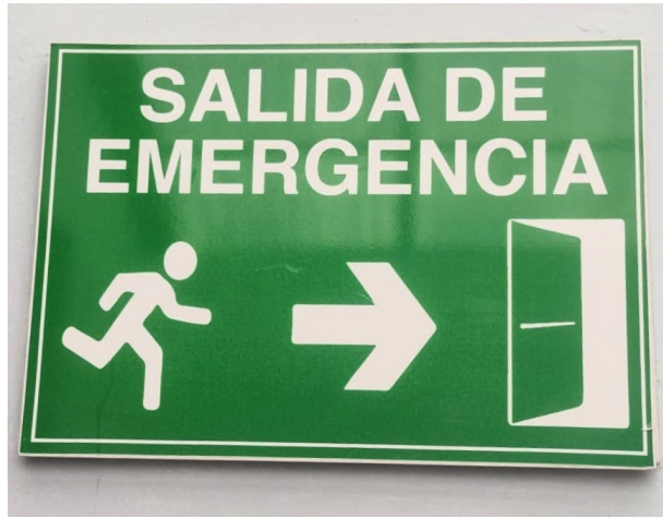
Figura 19: Señalización tipo estampado en el área de las escaleras
