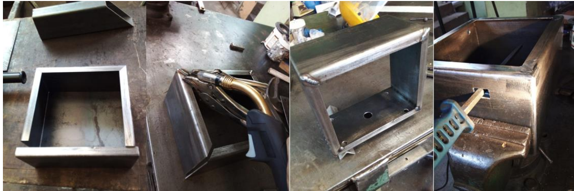
Figura 3-8 Construcción de gabinete.
