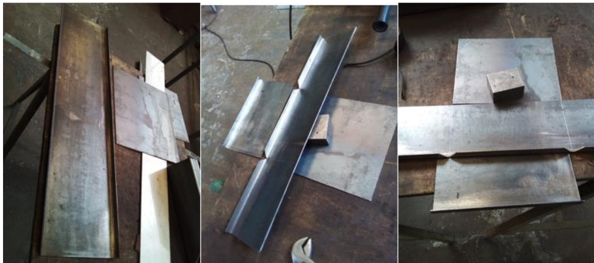
Figura 3-7 Preparación de plancha para gabinete.
