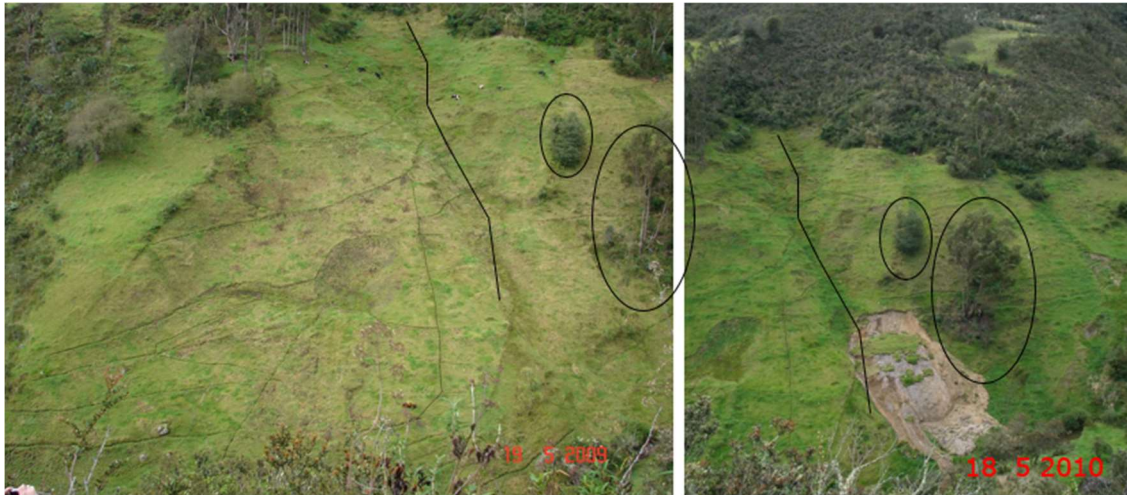
Imagen 89 Antes y después del deslizamiento
