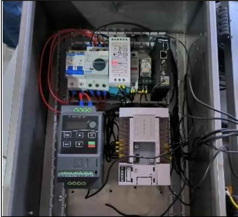
Figura 30: Montaje del tablero de control en la planta. (Fárez & Masalema, 2023)
