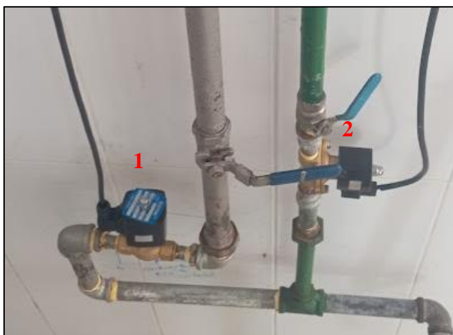
Figura 32: Electroválvulas implementadas. (Fárez & Masalema, 2023)
