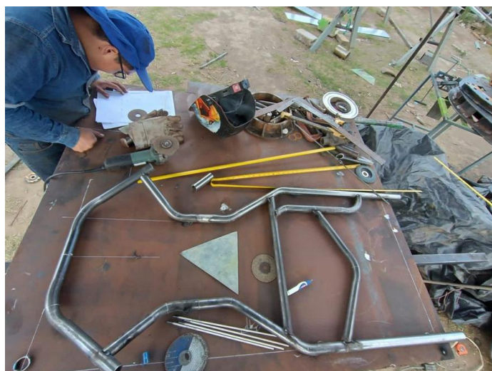
Posicionamiento y soldadura de elementos, Fuente: Álvaro Pillajo
