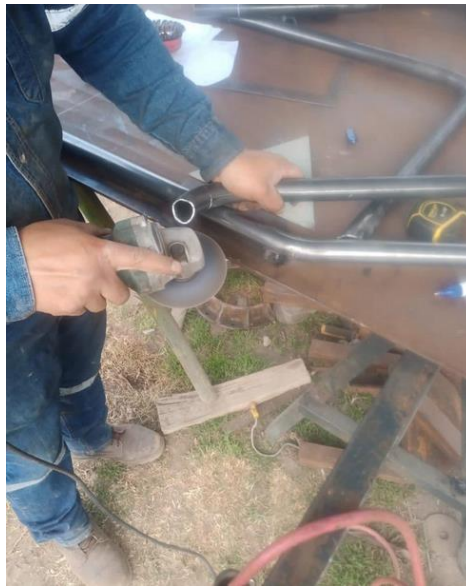
Operación de corte con amoladora,
