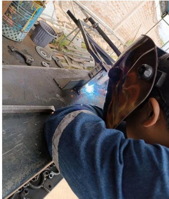
Ensamblaje por soldadura con electrodo E6011, Fuente: Álvaro Pillajo.
