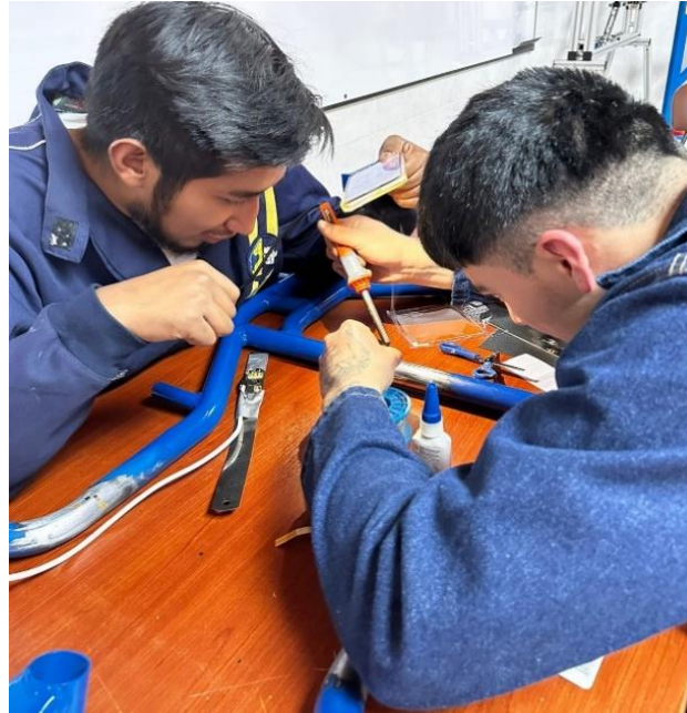
Conexión de cableado estructural, Fuente: Álvaro Pillajo
