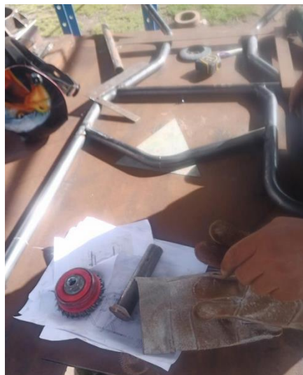
Limpieza de elementos usando limas y esmeril, Fuente: Álvaro Pillajo
