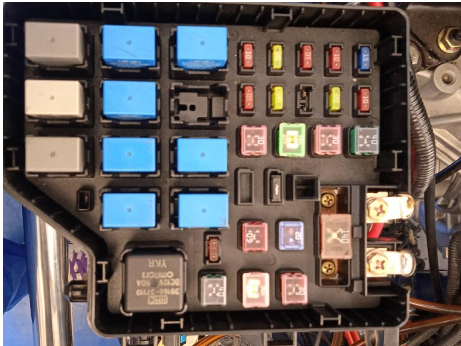
Figura 3.1.2. (3) Inspección Técnica de la fusilera.
