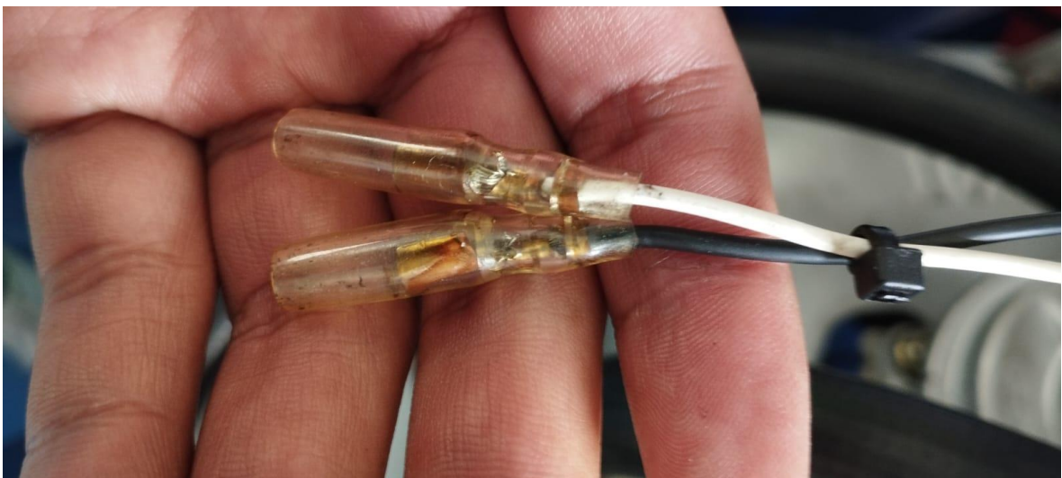
Figura 3.2.2. (4) Cambio de terminales.
