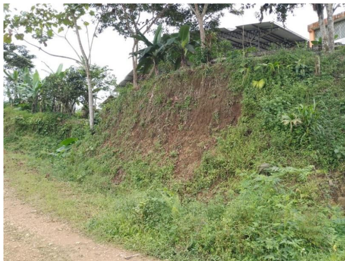
Figura 21. Área de deslizamiento.
