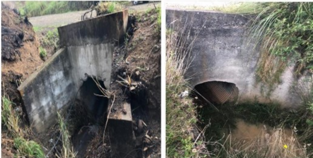
Ilustración 28. Estructura Cabezal - Cabezal
