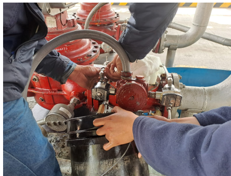
Figura 1.6: Cambio de válvulas solenoides 1.6
