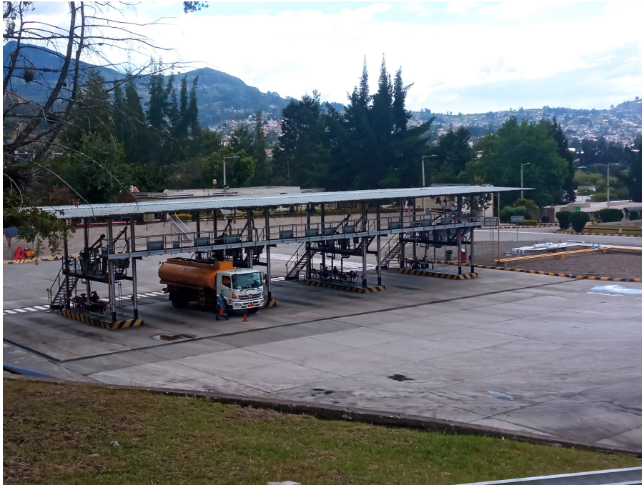
Figura 3.2: Islas de despacho de Productos Limpios
