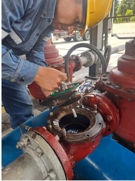
Figura 1.3: Válvula de diafragma
