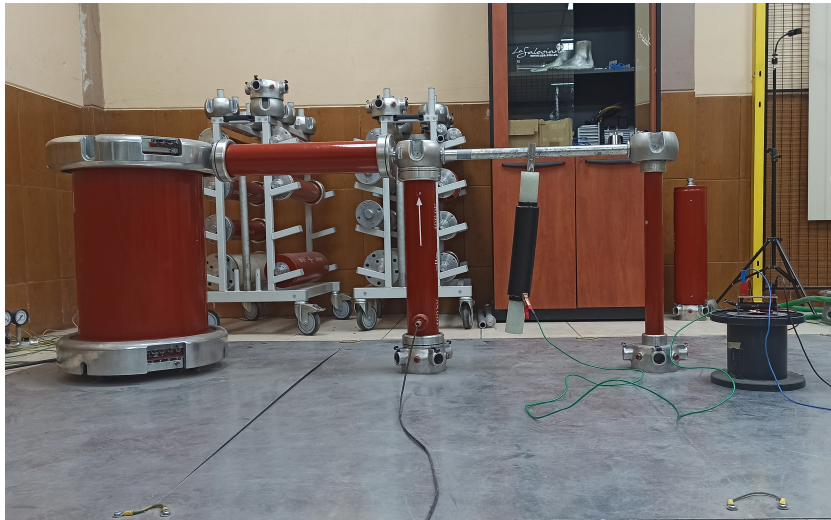
Figura 27: Circuito armado en el Laboratorio de Alta Tensión de la UPS.
