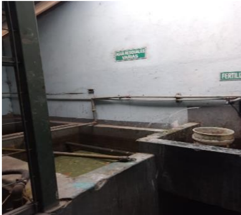
Anexo 10 Piscina de aguas residuales
