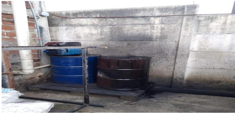
Anexo 3 Tanques para el almacenamiento temporal de aceite saturado
