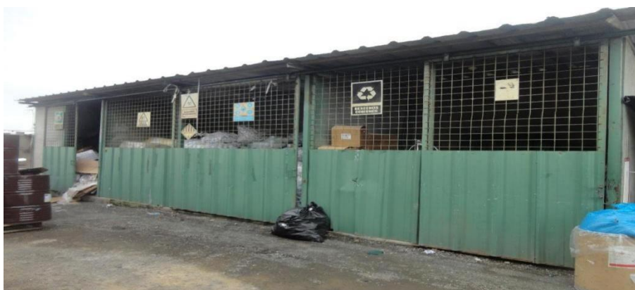
Figura 10 Área temporal de almacenamiento de desechos
