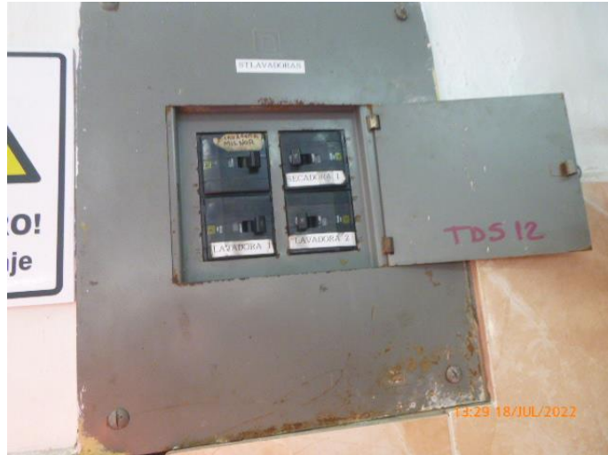
Figura 1 Registro fotográfico del TDS 12.
