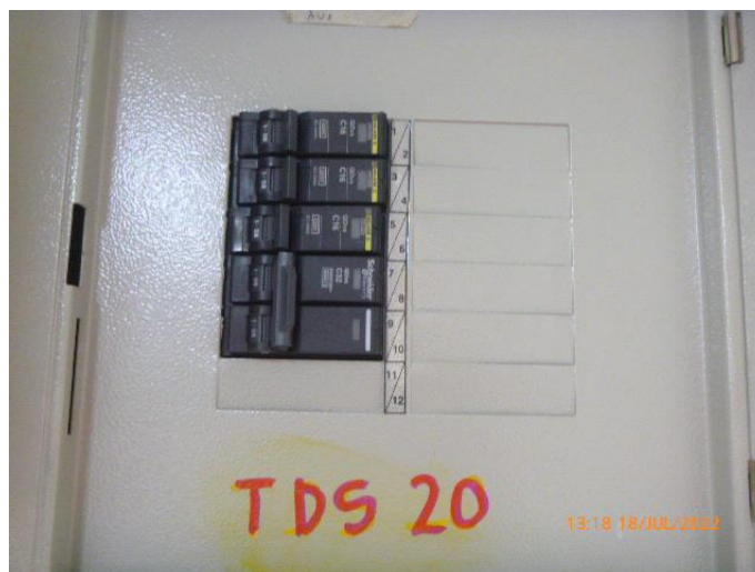
Figura 32 Registro fotográfico del TDS 20.
