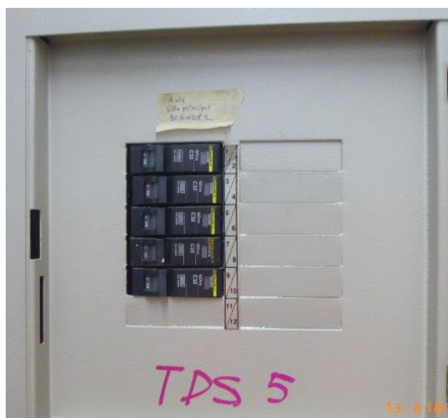
Figura 18 Registro fotográfico del TDS 5.
