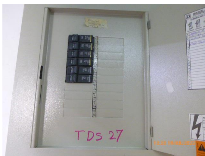
Figura 36 Registro fotográfico del TDS 27.
