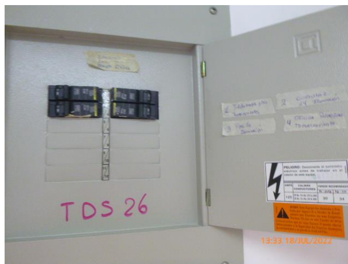
Figura 35 Registro fotográfico del TDS 26.
