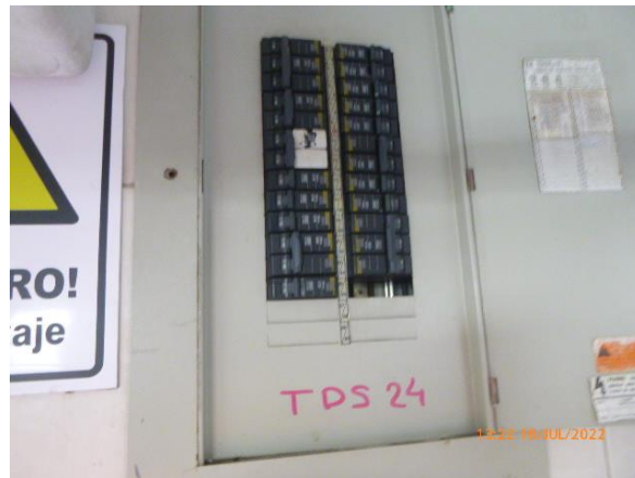
Figura 2 Registro fotográfico del TDS 24.
