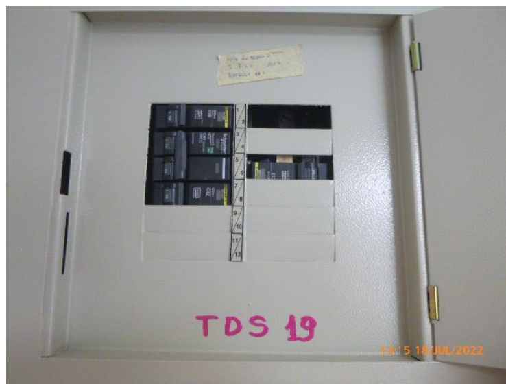
Figura 31 Registro fotográfico del TDS 19.
