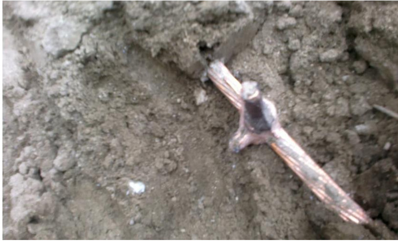
Figura 52. Suelda exotérmica en varilla copperweld. Fuente: Autor.
