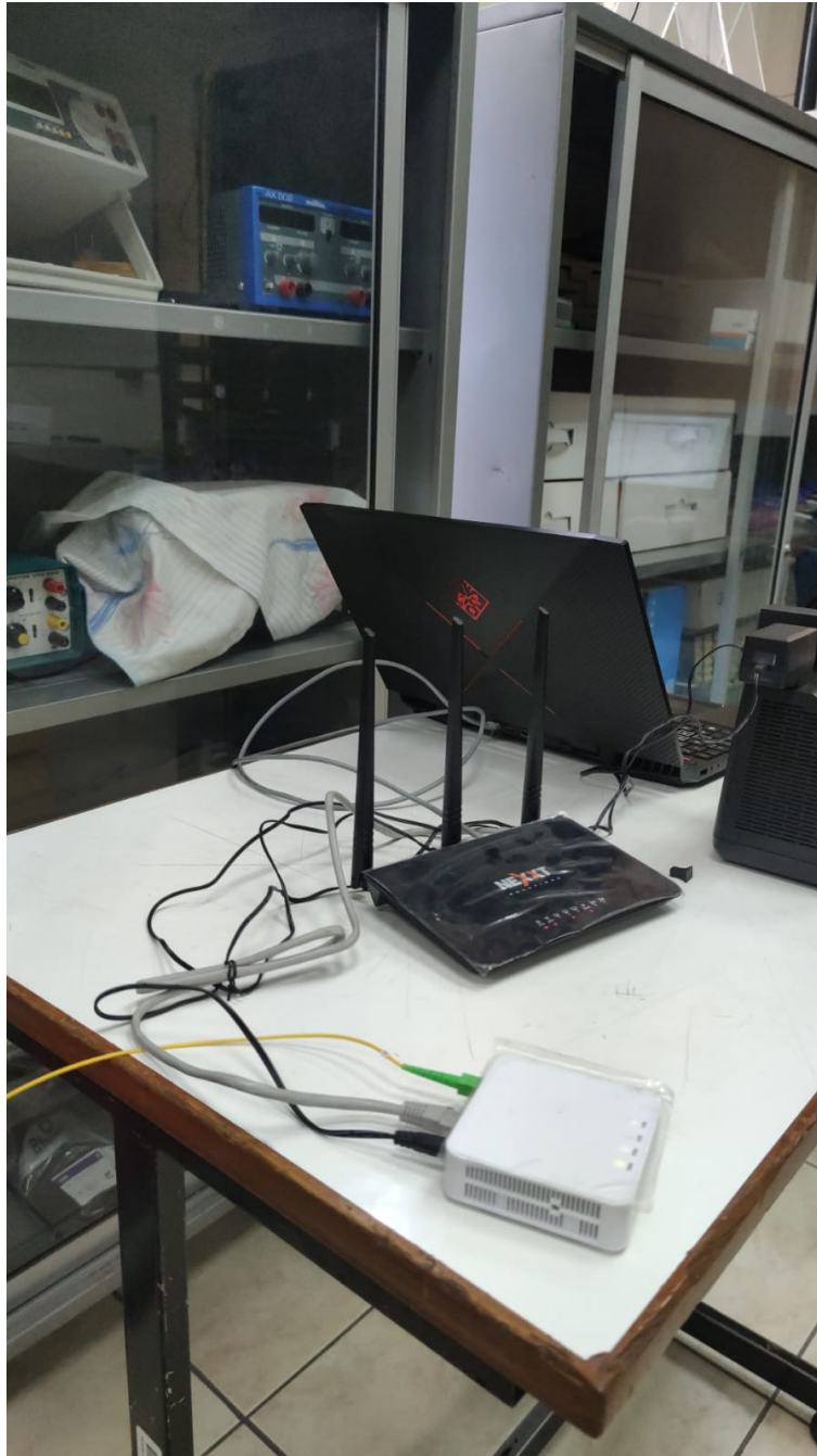
Figura 2.10: Conexión para la prueba y verificación.
