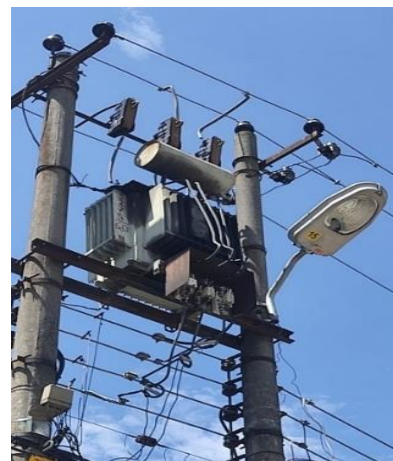
Figura 8. Transformador sin efecto térmico.
