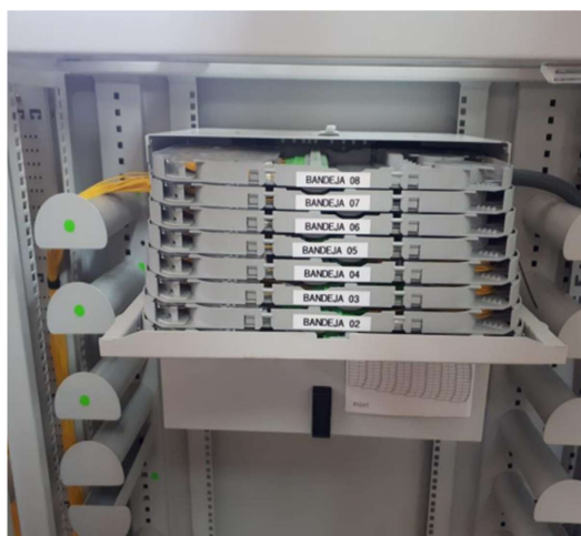
Figura 1.6: Ejemplo de un ODF. Fuente [32].
