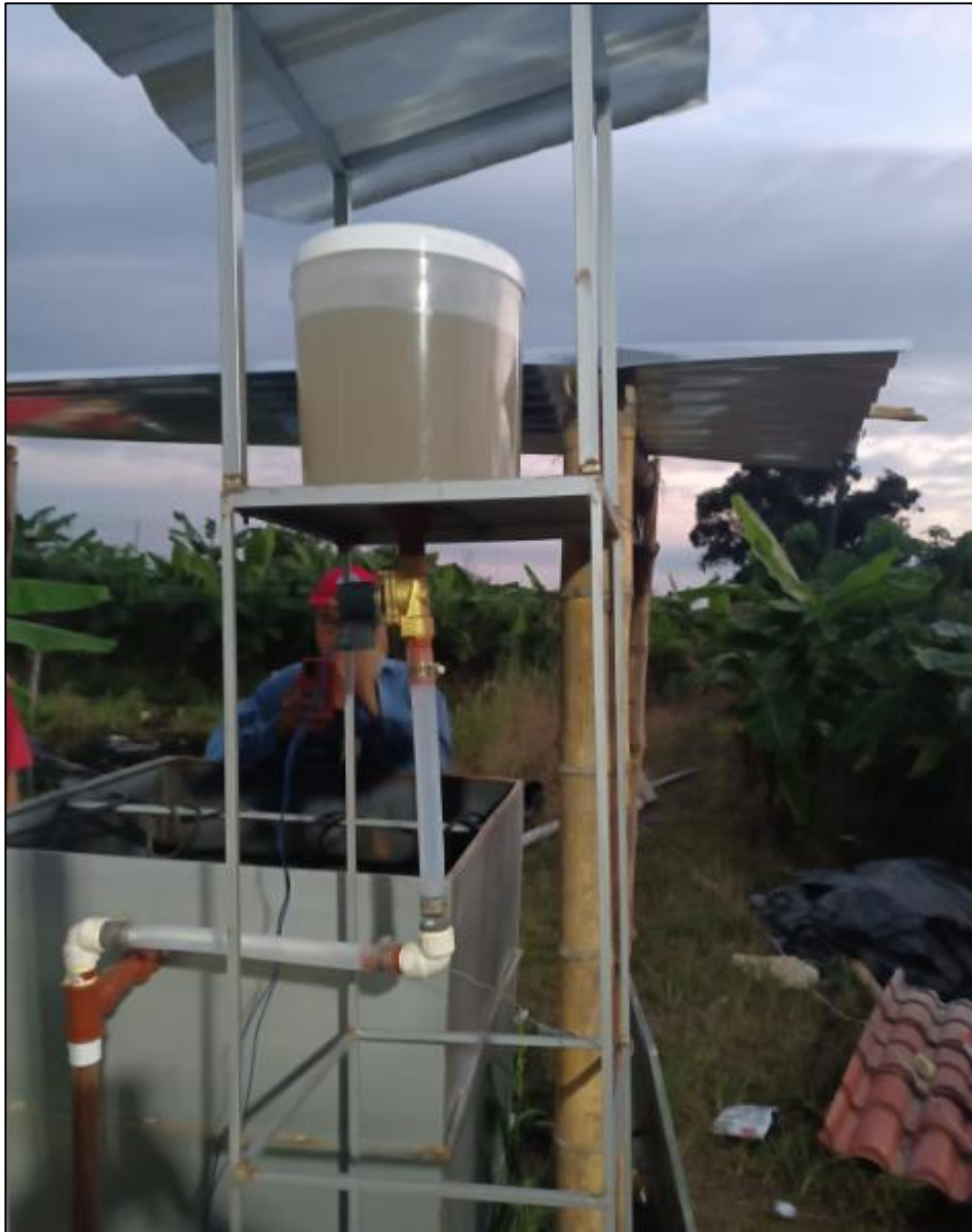
Anexos-14 Dispensador conectado a electroválvula operativo.
