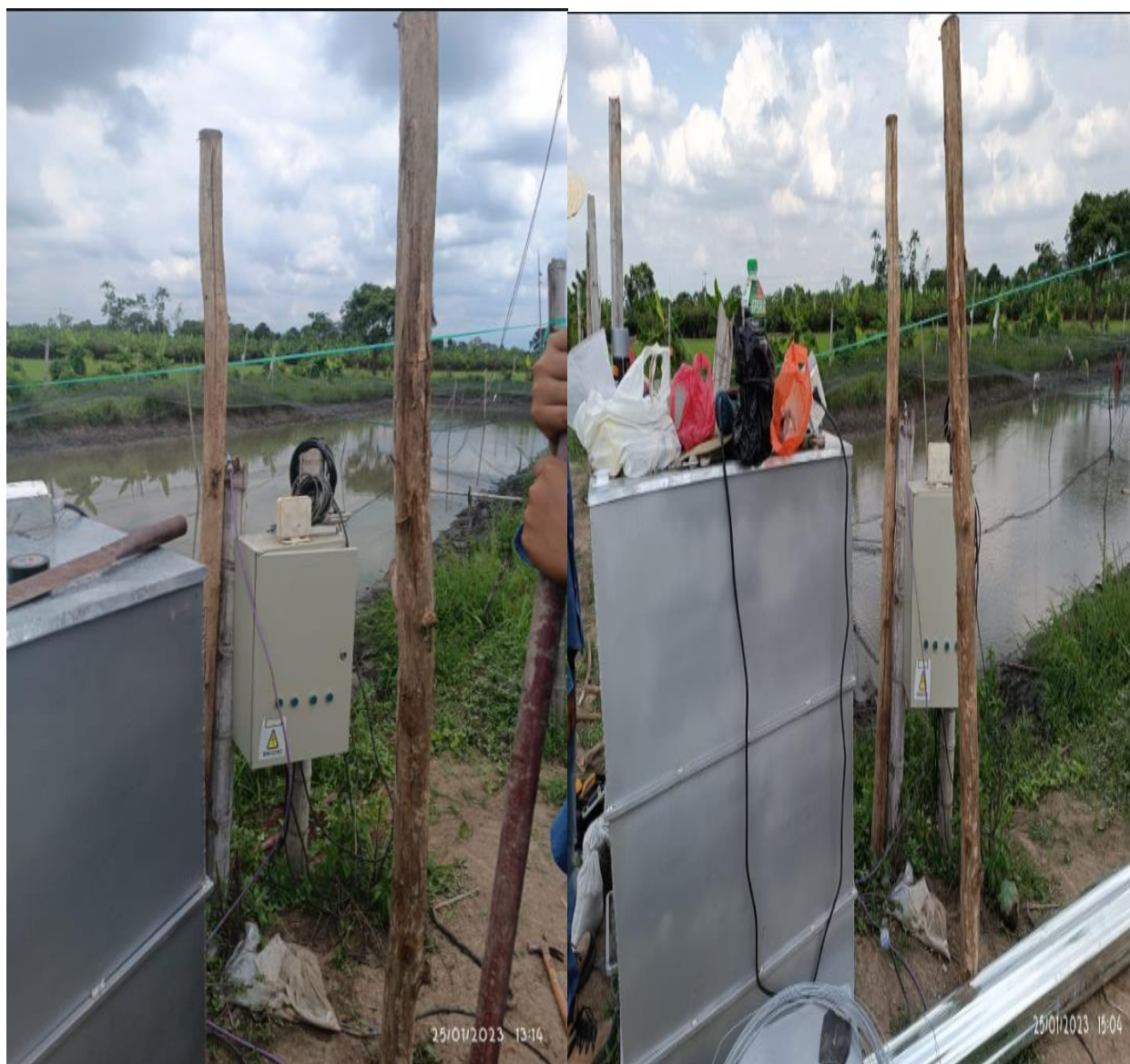
Anexos-7 Colocación de palos de Teca para techo.
