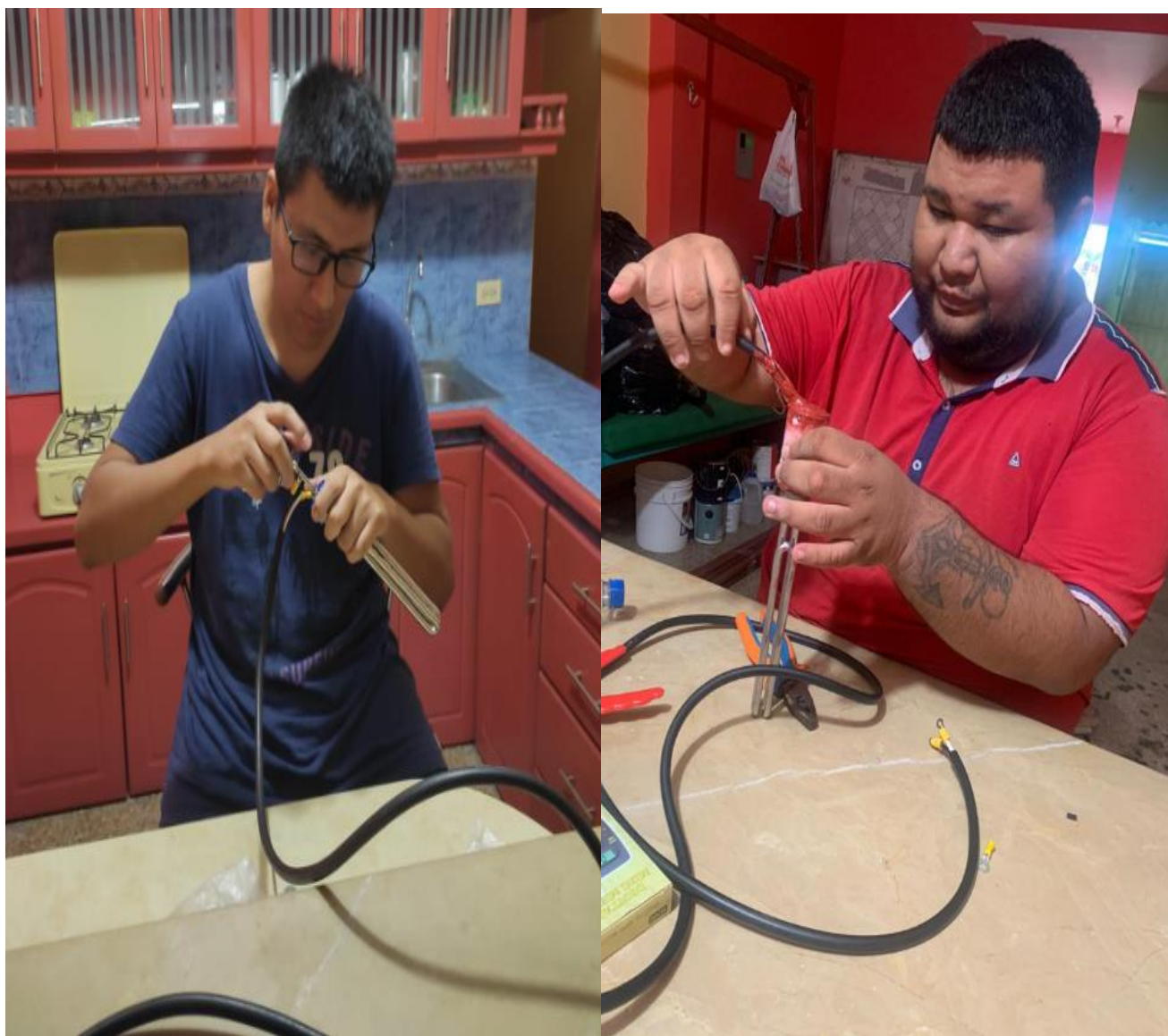
Anexos-6 Colocación de aislante a las resistencias calentadoras.
