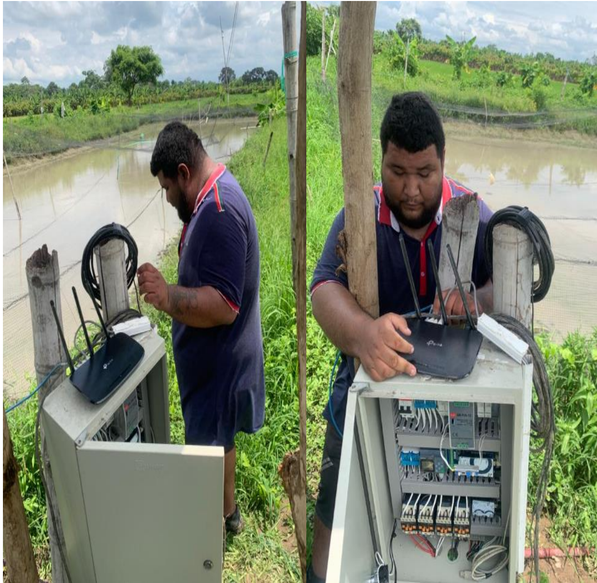
Anexos-5 Colocación y configuración de nuevo Router.
