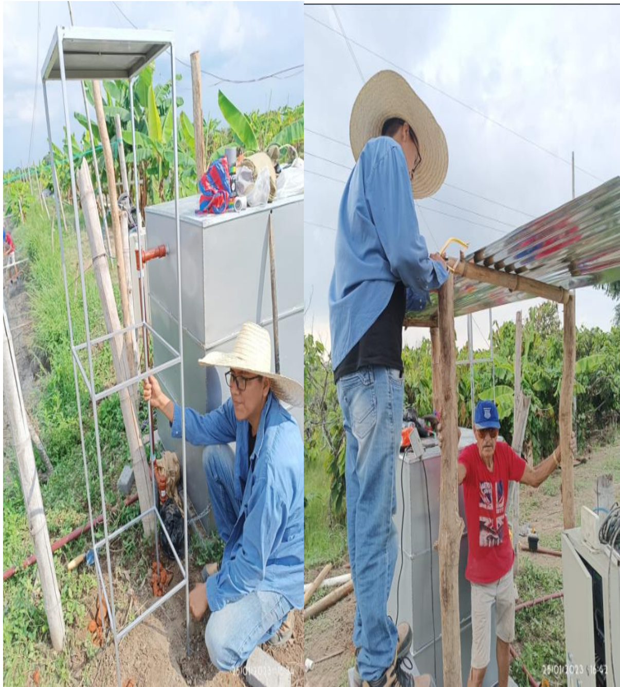
Anexos-9 Colocación de estructura metálica y ajuste de techo.
