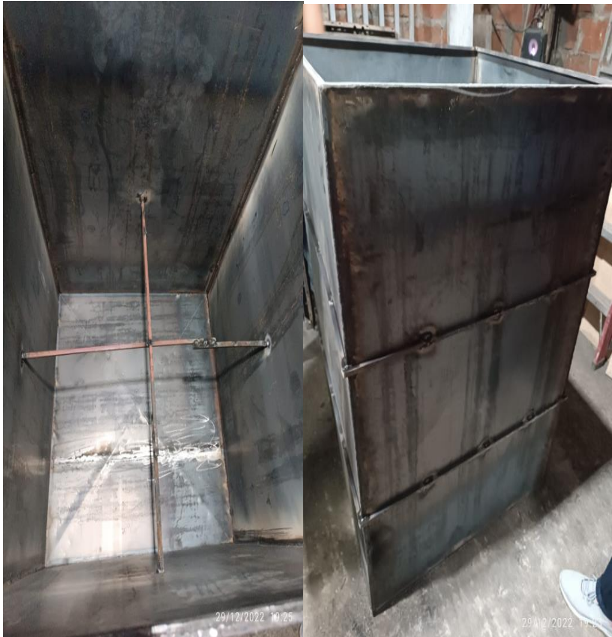
Anexos-3 Elaboración de tanque metálico.
