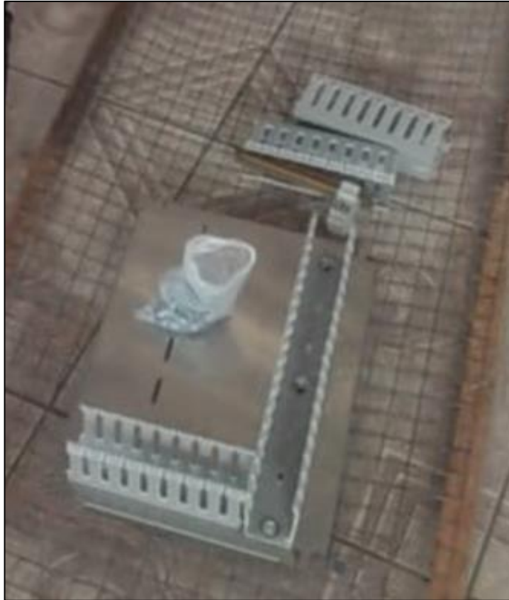
Marco metodológico-15 Colocación de riel DIN y canaletas
