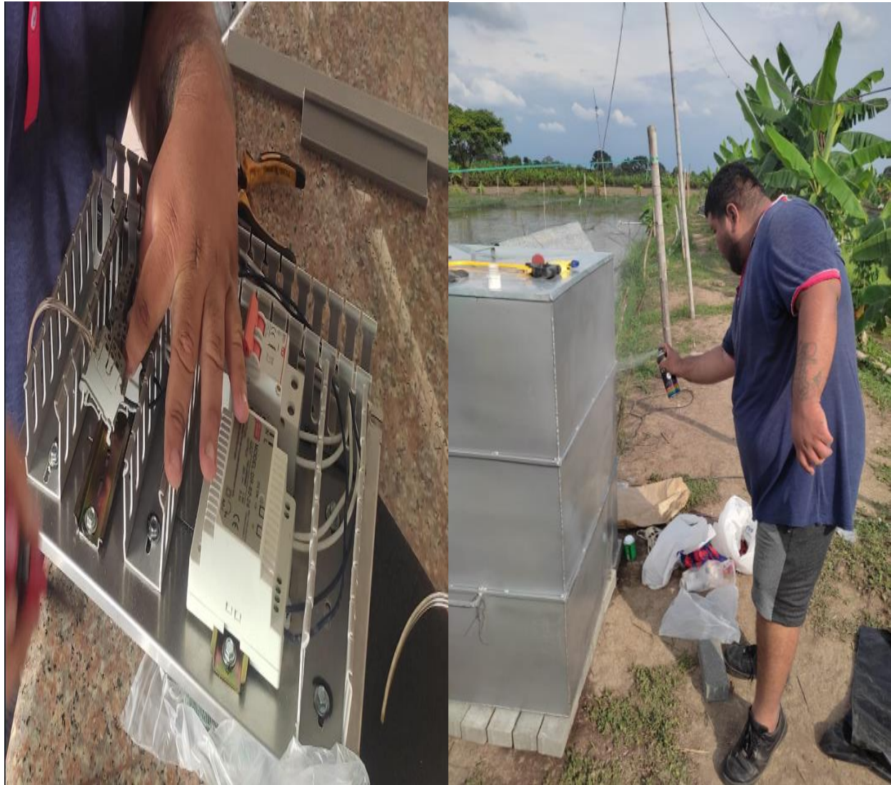
Anexos-1 Elaboración de tablero para HMI y pintada de tanque metálico.
