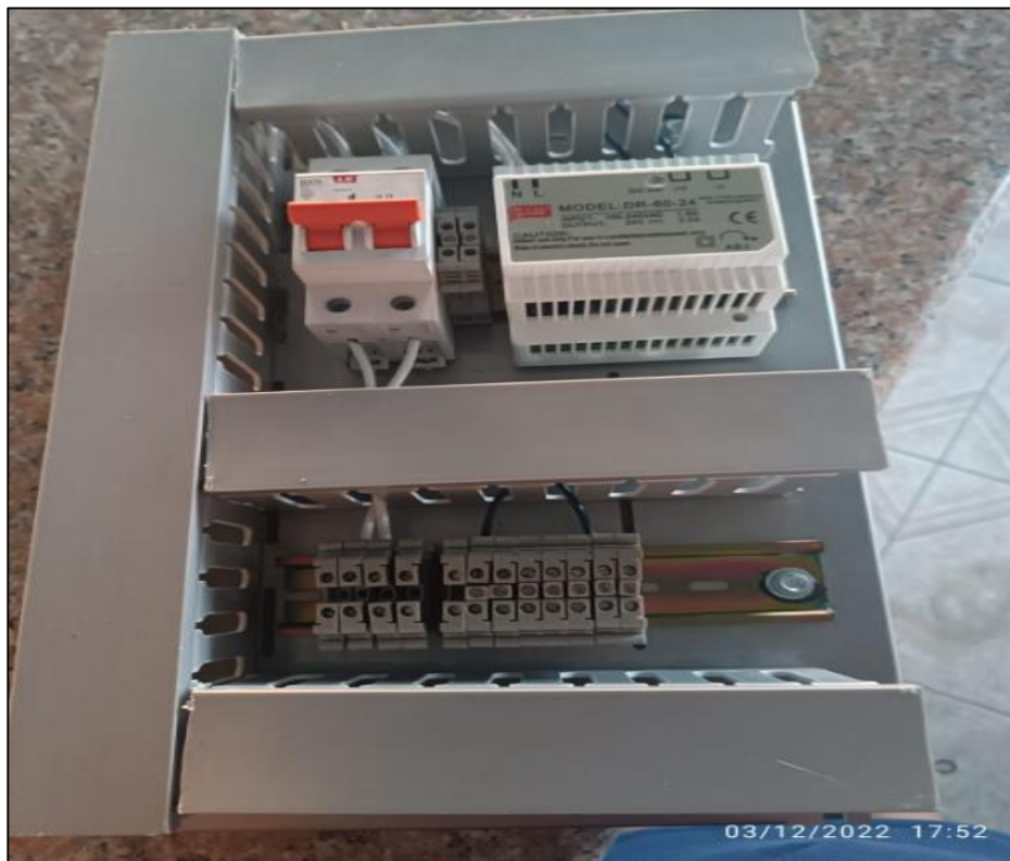
Marco metodológico-17 Ensamblaje casi terminado de tablero.
