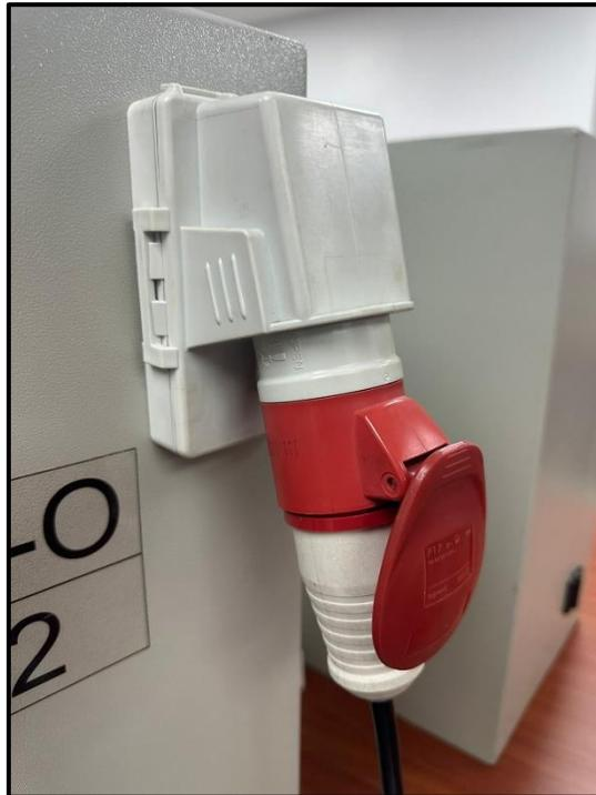
Anexo 2. Conector tipo clavija IP 44 marca Legrand – Macho
