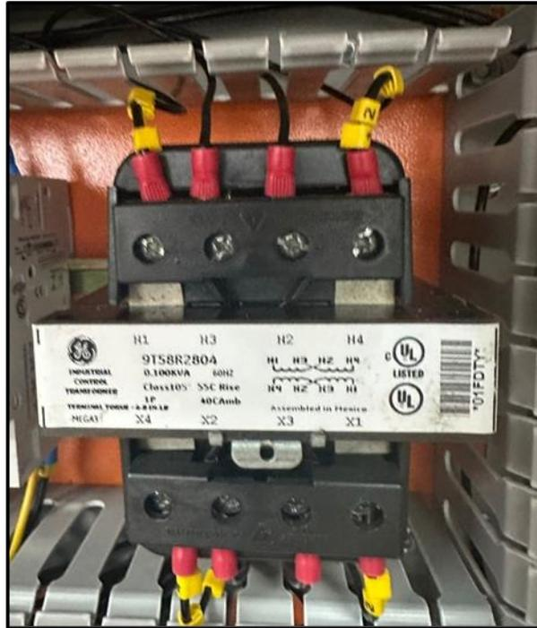
Anexo 3. Transformador de potencia 440v/220v
