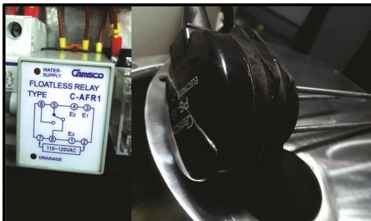
Figura 50. Relé de nivel y Sondas marca CAMSCO
