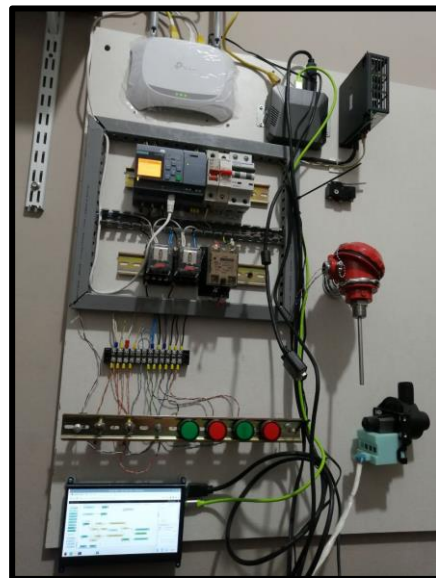
Figura 121. Montaje del tablero de control para desarrollo de las practicas
