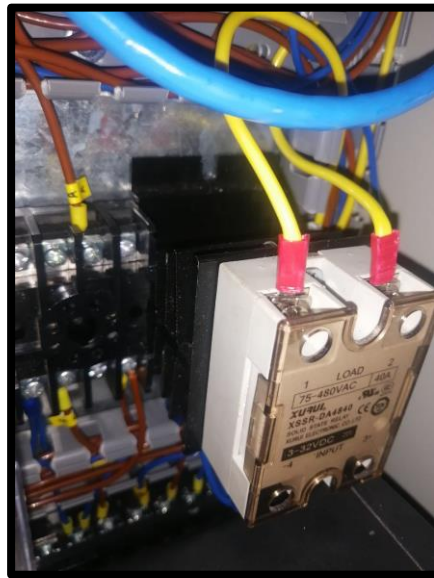
Figura 115. Disipador y Relé de estado solido
