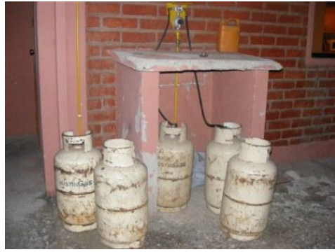
CENTRALILLA DE GAS.
