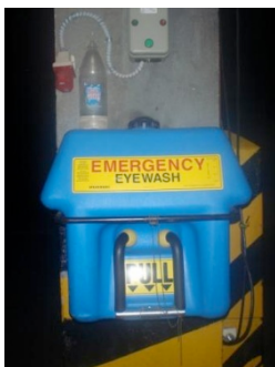
SE RECOMIENDA QUE EL LAVADOR DE OJOS SEA REUBICADO DEBIDO A CERCANÍA CON LAS INSTALACIONES ELÉCTRICAS.
