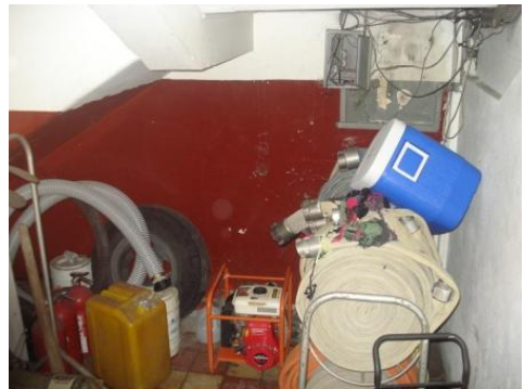
BODEGA. EL SISTEMA ELÉCTRICO EN MALAS CONDICIONES.
