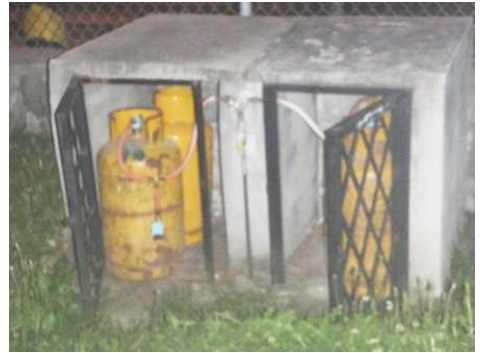
CENTRALILLA DE GAS.
