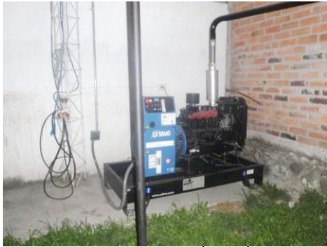
GENERADOR DE ENERGÍA ELÉCTRICA.
