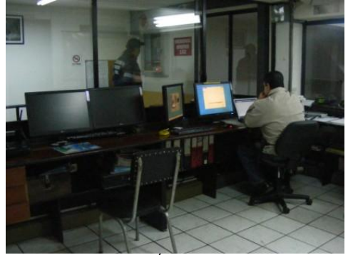
MANDOS DE CÁMARAS, PUERTAS ELÉCTRICAS Y SIRENA DE EMERGENCIAS.
