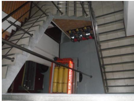
LA CASCADA SE ENCUENTRA MUY CERCA DEL TUBO DE EMERGENCIA.
