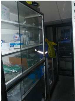
BODEGA DE INSUMOS Y TABLERO DE CÁMARAS.
