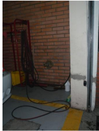
MANGUERA PARA LAVADO DE VEHÍCULOS. SE RECOMIENDA COLOCAR UNA PISTOLA PARA ADMINISTRACIÓN DEL AGUA.
