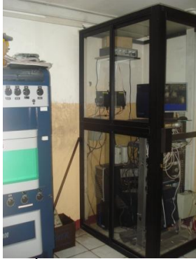
MANDO CÁMARAS DE LA ESTACIÓN.
