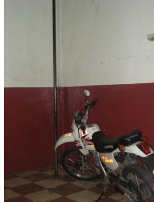
SE RECOMIENDA PINTAR ZONA DE SEGURIDAD ALREDEDOR DEL TUBO QUE DEBE SER RESPETADA PARA EVITAR ACCIDENTES.
