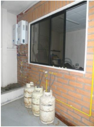
CENTRALIZACIÓN DEL GAS.
