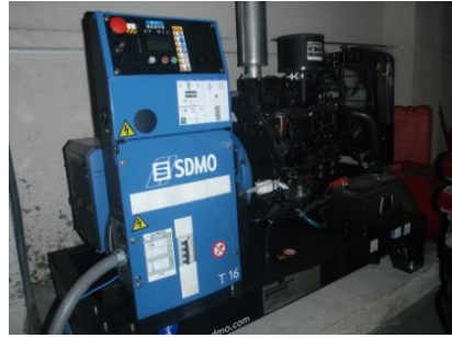
GENERADOR DE ENERGÍA ELÉCTRICA.
