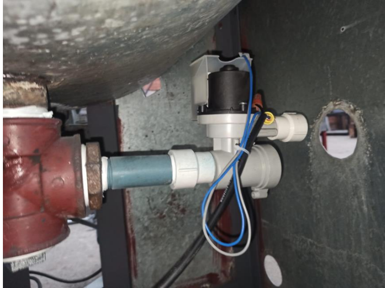
Figura 3.45: Implementación de bomba para desfogue.
