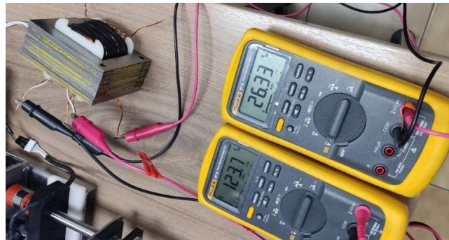
Figura 38. Medición devanado primario y secundario.
