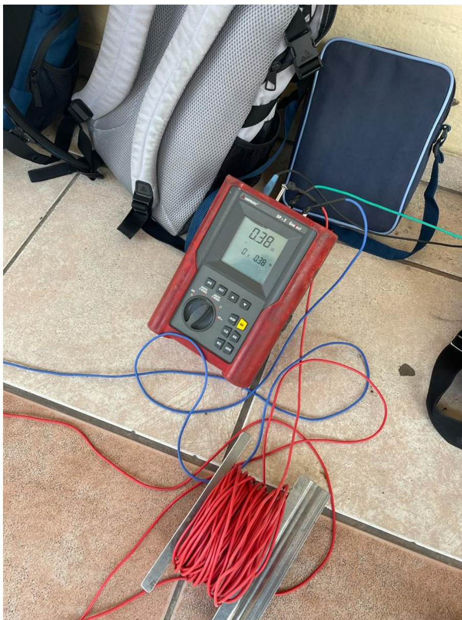
Figura A.3: Medición de resistencia de malla de puesta a tierra del edificio Mario Rizzini
