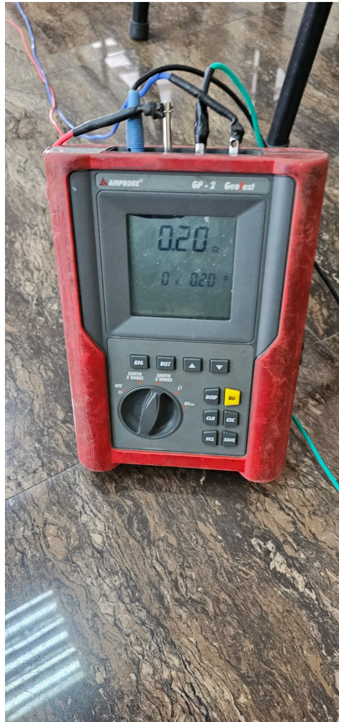
Figura A.8: Medición de resistencia de malla de puesta a tierra del edificio de Biblioteca
