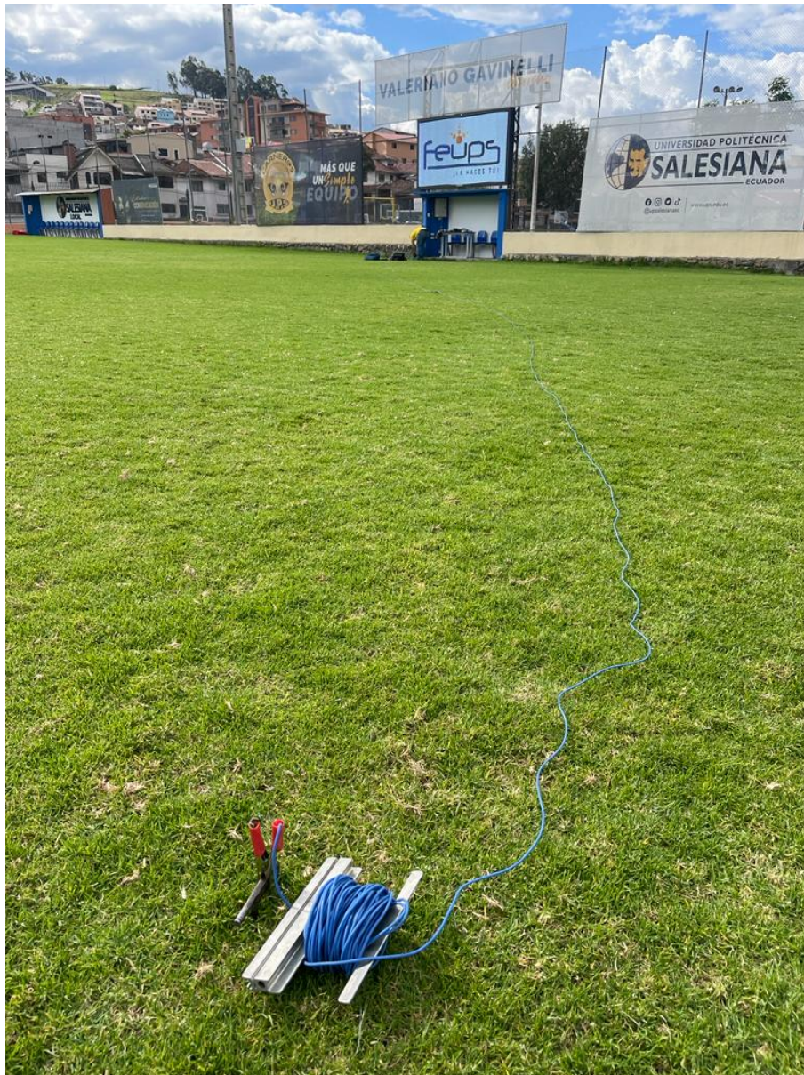
Figura A.4: Medición de resistencia de malla de la pantalla en la cancha de fútbol
