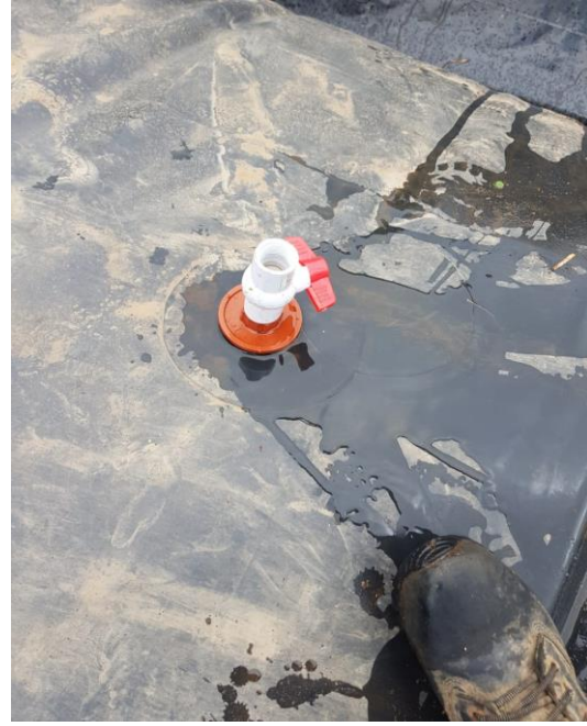
Anexos 10. Acoplamiento de llave de esfera a la válvula de salida de la bolsa de geomembrana
