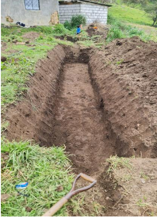
Anexos 5. Excavación con la una inclinación de 60°, para que la zanja se acople al biodigestor
