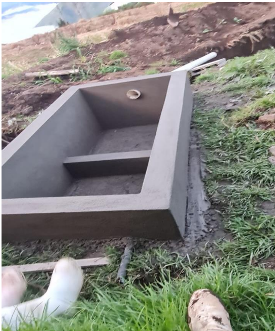
Anexos 7. Pozo de revisión, enlucido para evitar filtraciones
