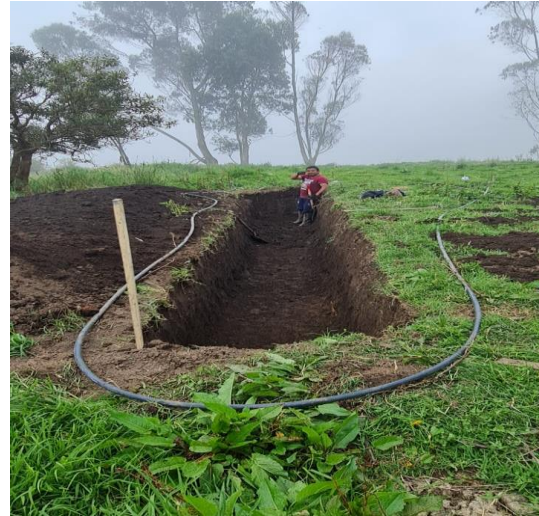
Anexos 2. Excavación del de la Zanja con un dimensión de 1x1 metros
