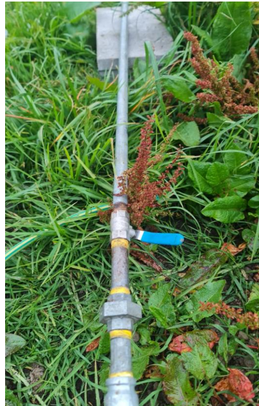
Anexos 12. Llave de esfera de metal para utilizar el biogás
