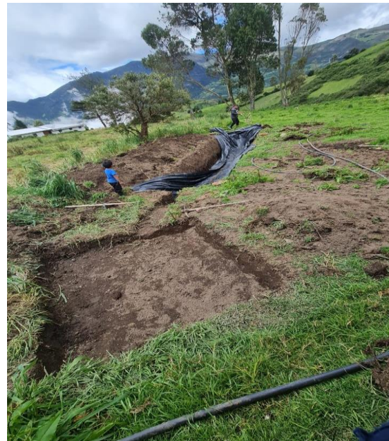
Anexos 4. Adecuamiento del terreno para elaboración de pozo de revisión de ingreso
