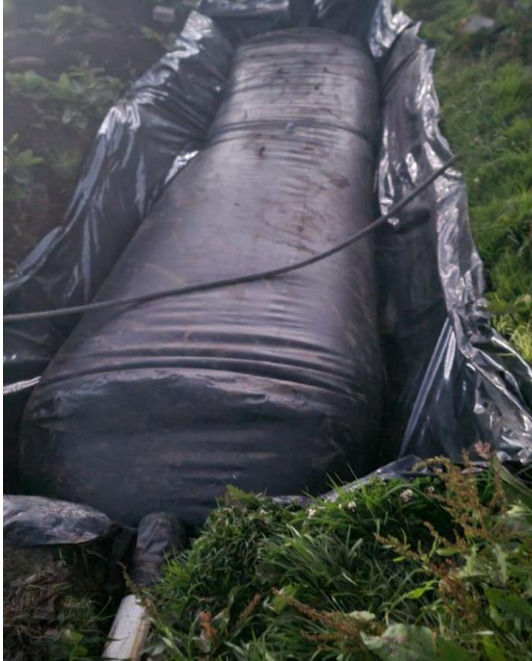
Anexos 9. Biodigestor emplazado con primera carga
