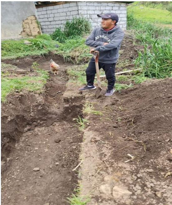
Anexos 3. Elaboración de la zanja para la tubería PVC
