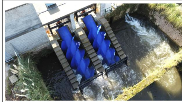
**Nota:** En la Figura se aprecia el uso de tornillos sinfín paralelos para la generación de energía eléctrica en un proyecto español de Sinfin Energy, tomado de (Sinfin Energy, 2019).
