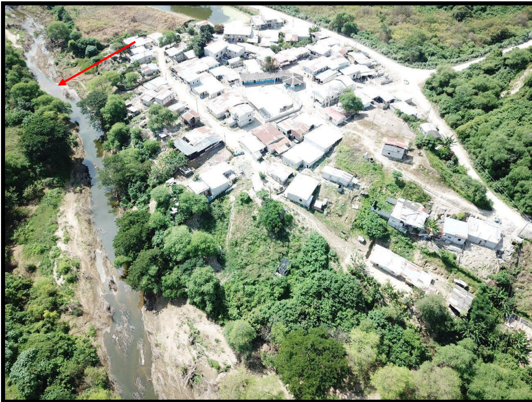
ILUSTRACIÓN 16 ZONA DE DESCARGA
