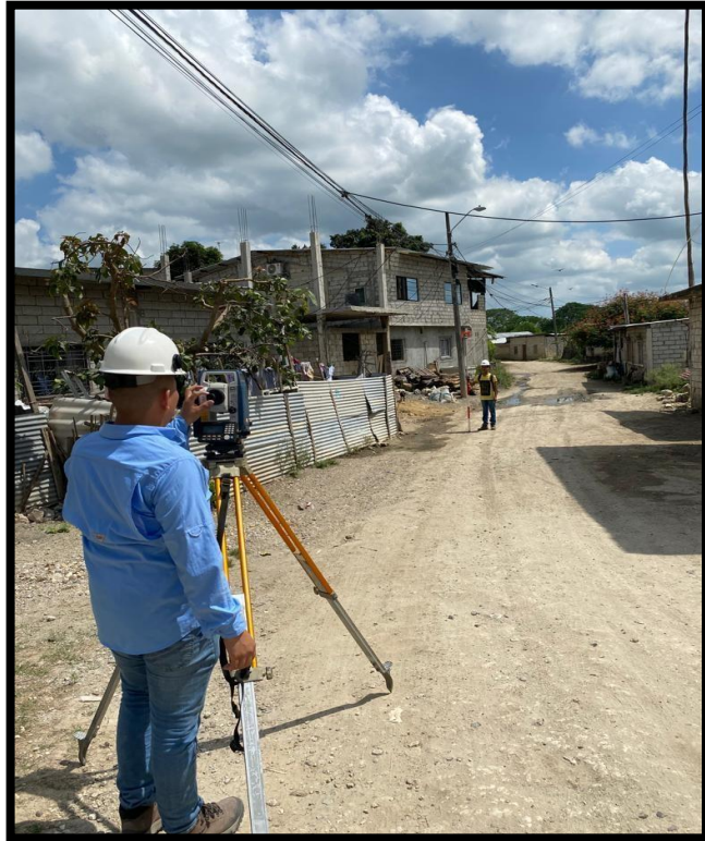
ANEXOS 3 OBTENCIÓN DE PUNTO TOPOGRAFICO CON EL PRISMA
