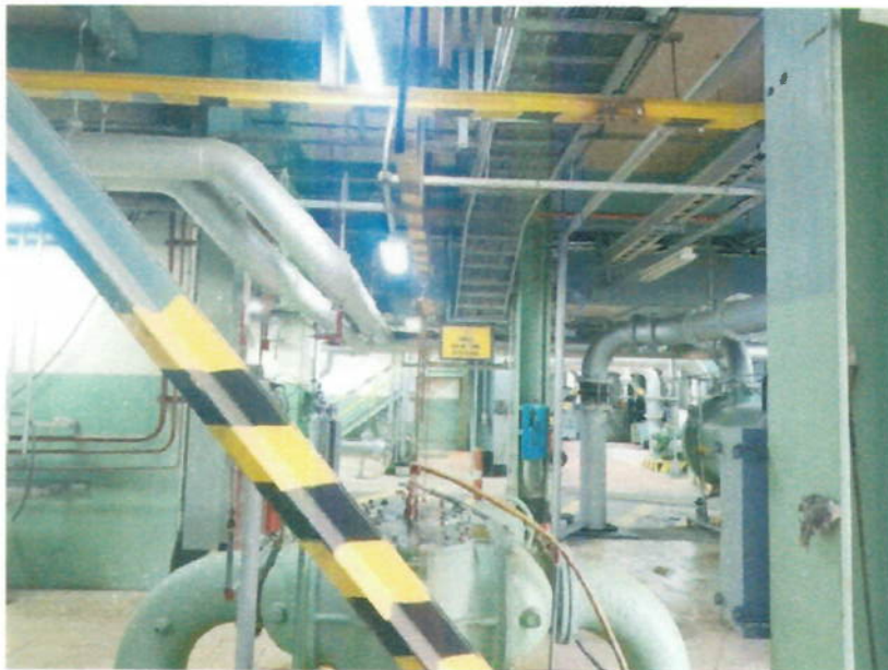
Figura 16. Estructura implementada parte 2
