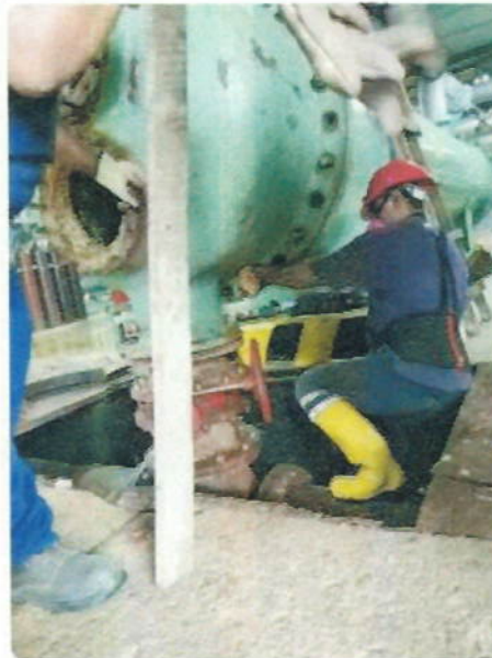
Figura 2. Desmontaje de equipo utilizando herramientas manuales
