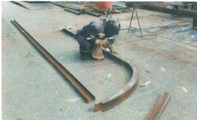
Figura 12. Construcción sistema de rieles
