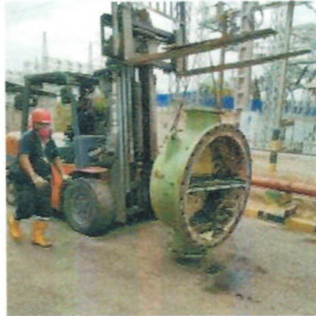
Figura 1. Desmontaje de equipo con montacarga
