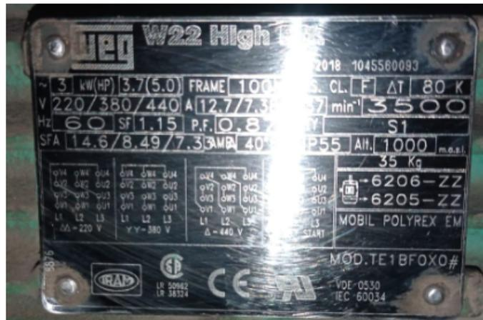
**Nota:** Se observa en la figura los parámetros que tiene la bomba centrífuga que se esta empleando en la empresa para el sistema de enfriamiento.
