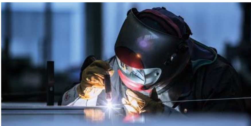
Figura 5 Soldadura con arco de tungsteno y gas
