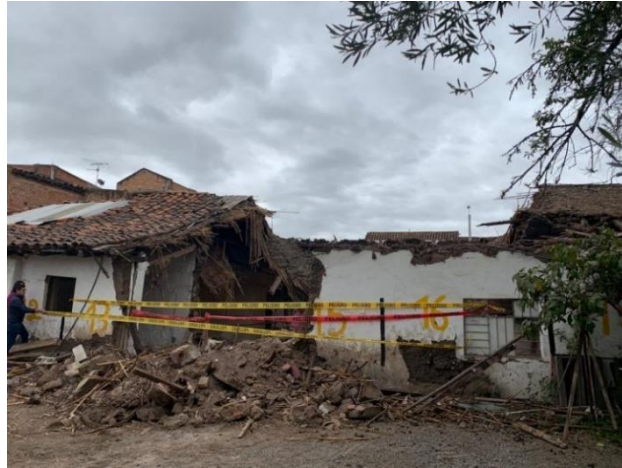
Figura 18. Casa patrimonial colapsada por daño estructural [25].
