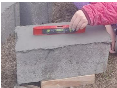
Imagen 8: Nivelación de la capa de mortero.
