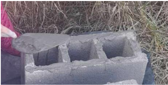
Imagen 6: Recubrimiento de las caras del bloque.
