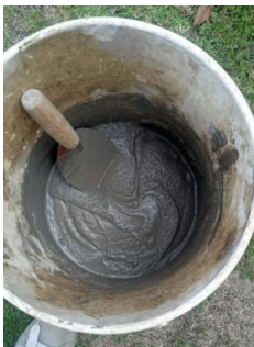
Imagen 5: Mezcla del mortero.
