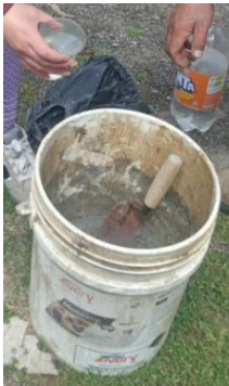
Imagen 4: Preparación del mortero.
