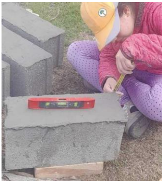
Imagen 7: Medición de la capa de mortero de 6mm.
