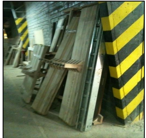
Material mal almacenado
