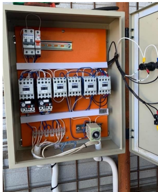
Figura 36 Construcción del tablero eléctrico.
