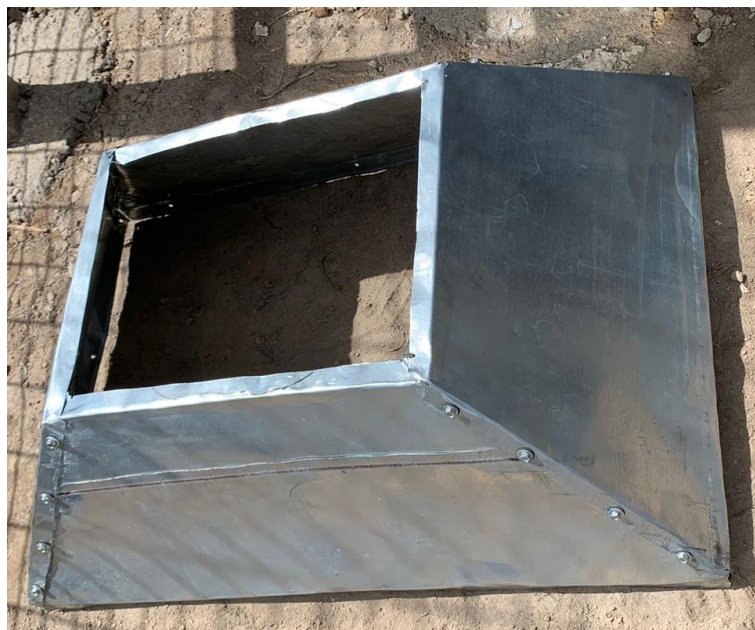
Figura 31 Construcción de la campana de extracción
