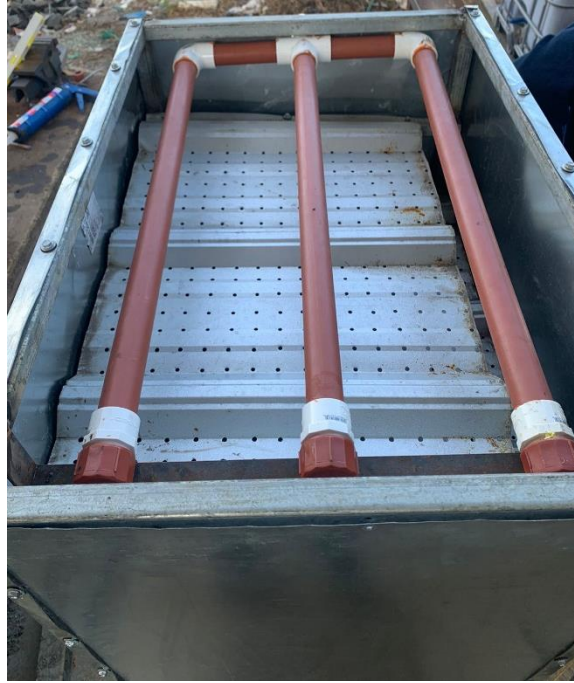
Figura 35 Instalación de tubería para la salida de agua caliente
