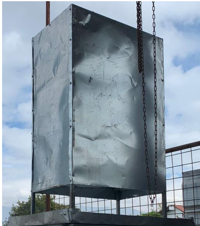
Figura 34 Construcción de las paredes del sistema de enfriamiento
