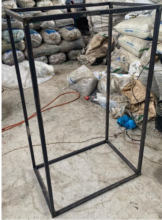
Figura 30 Construcción de la estructura del sistema de enfriamiento
