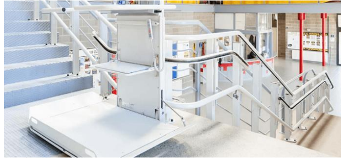
Figura 6. Ejemplo de Elevador inclinado.
