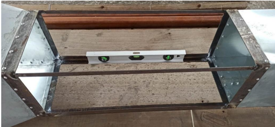
Figura 2.19 Unión de la estructura
