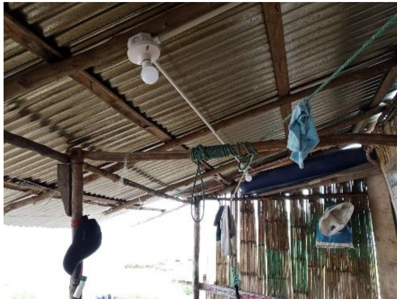
Anexos 16 Montaje de Luminarias en Sala (Autoría Propia)
