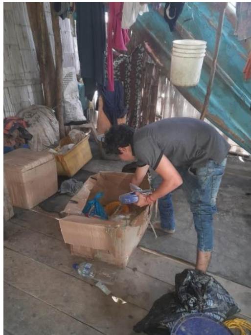
Anexos 6 Desmontaje de Material Eléctrico (Autoría Propia)
