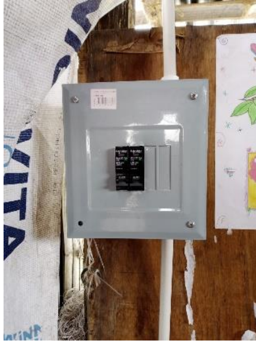
Anexos 13 Instalación de Panel de Distribución (Autoría Propia)
