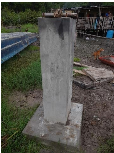
Anexos 4 Base de Hormigón para Colocar el SF (Autoría Propia)
