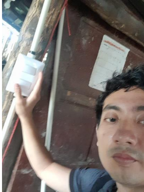
Anexos 17 Colocación de los Interruptores (Autoría Propia)
