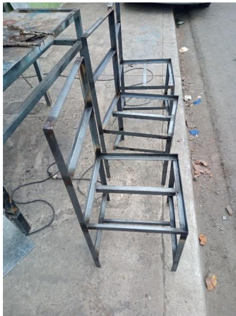
Anexos 21 Elaboración de los Soportes Para SF (Autoría Propia)
