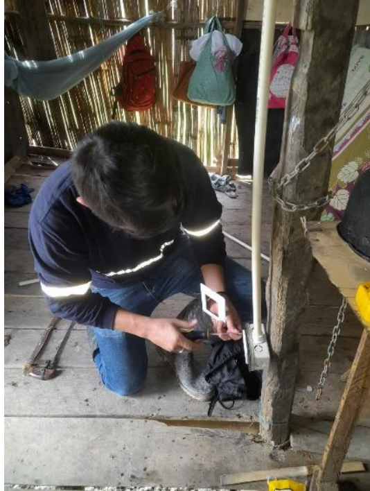
Anexos 7 Montaje de Toma Corrientes (Autoría Propia)
