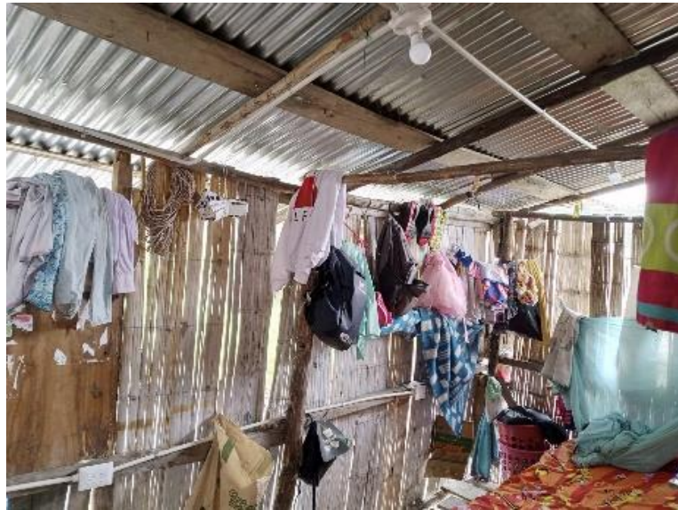
Anexos 15 Montaje de Luminarias (Autoría Propia)
