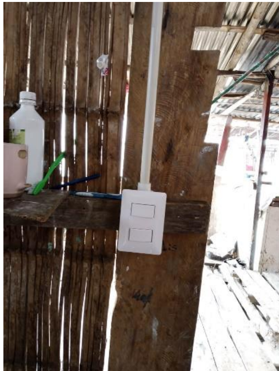
Anexos 14 Instalación de Interruptor (Autoría Propia)
