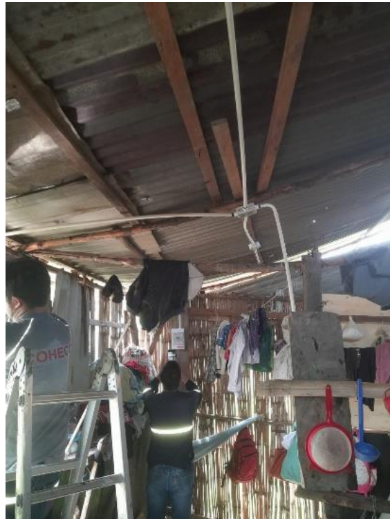
Anexos 8 Montaje de Luminarias (Autoría Propia)
