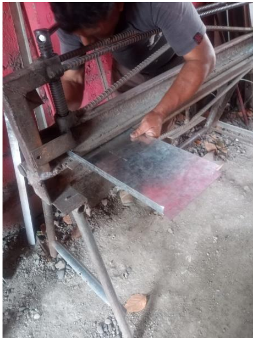
Anexos 23 Ensamblaje de Bases SF (Autoria Propia)
