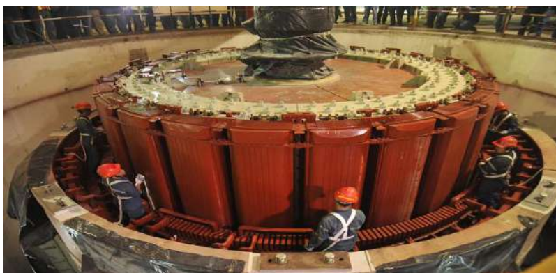
Figura 2: Estructura del generador. [7]
