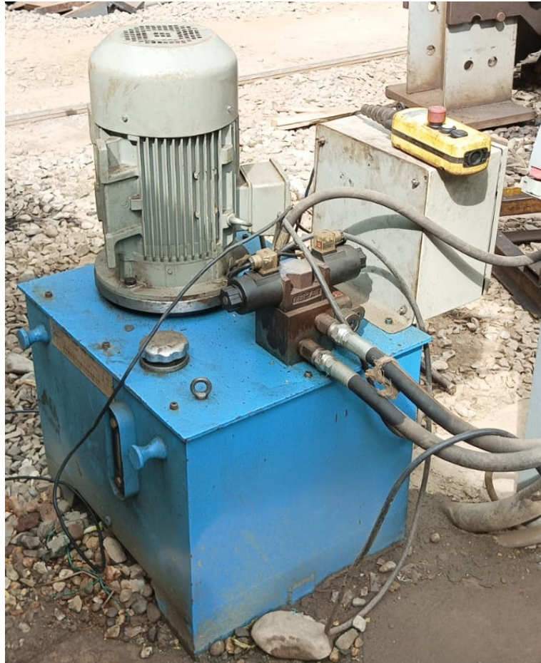
Figura 99. Instalación de central hidráulica, por M. Aguilar y E. Pincay
