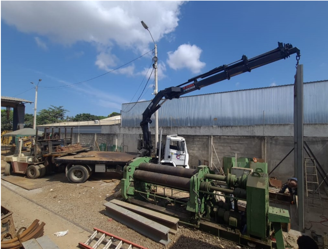
Figura 95. Montaje de columnas o vigas con grúa y la ayuda del montacarga , por M. Aguilar y E. Pincay
