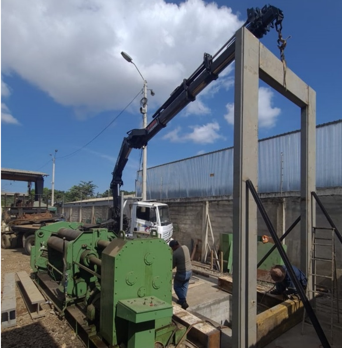
Figura 96. Montaje de columnas o vigas con grua y la ayuda del montacarga , por M. Aguilar y E. Pincay
