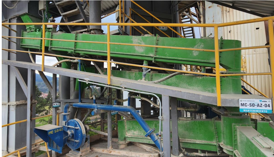
Figura 14. Aerodeslizador de la salida del elevador MV-EC-MT01 instalado.
