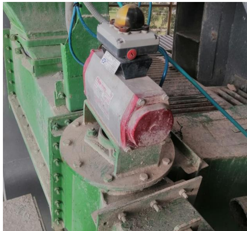
Figura 15. Compuerta del aerodeslizador de la salida del elevador MV-EC-MT01 instalado.
