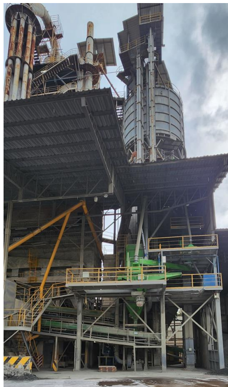
Figura 2. Infraestructura completa del proyecto.
