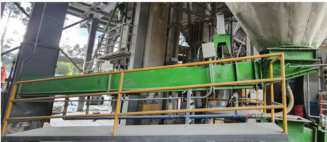
Figura 7. Aerodeslizador con compuerta proporcional instalada.
