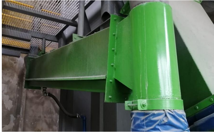
Figura 10. Aerodeslizador que alimenta la zaranda instalada.
