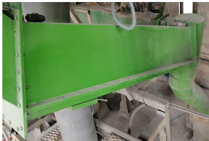
Figura 13. Aerodeslizador del filtro instalado.
