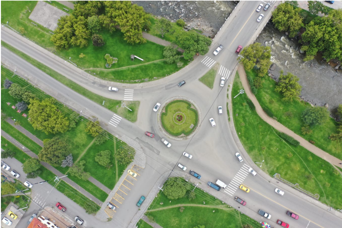
Ilustración 3.2: Foto de la Intersección captada por dron. Fuente: Autores.
